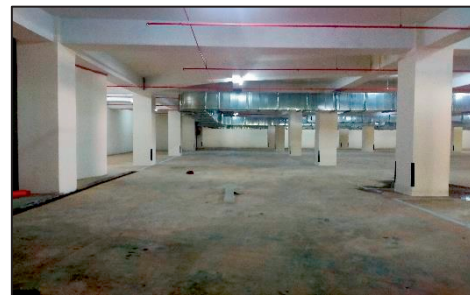
Jertih Square - Sub-Basement-Parking Masih Dalam Pembinaan (10.03.2021) (Sumber: Jabatan Audit Negara)
