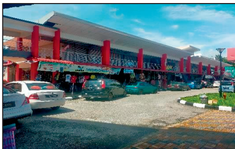
Jertih Square - Ruang Niaga Siap Dibina (10.03.2021) (Sumber: Jabatan Audit Negara)
