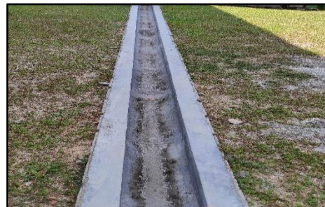
Longkang, SJK(T) Ladang Semenyih - Longkang yang Telah Dibina di Arena Utama dan Bangunan Sekolah (04.03.2021) (Sumber: Jabatan Audit Negara)
