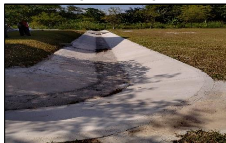
Padang Sekolah, SJK(T) Ladang Semenyih - Earth Drain yang Telah Siap Dibina (04.03.2021) (Sumber: Jabatan Audit Negara)
