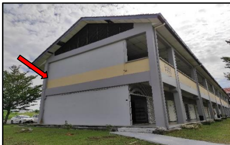
Bangunan Dua Tingkat, SJK(T) Ladang Semenyih - Bangunan Sekolah yang Telah Dicat (08.04.2021) (Sumber: Jabatan Audit Negara)
