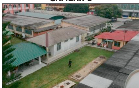
Nilam Puri, Kota Bharu - Bangunan KIAS (15.10.2020) (Sumber: Jabatan Audit Negara)
