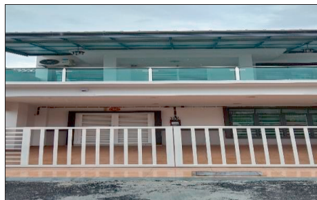
Lot 1035 (BB 46), Taman Vista Belimbing, Alor Gajah - Pegangan Tidak Dinilai Semula Selepas Siap Ubah Tambah Bangunan (24.03.2021) Sumber: Jabatan Audit Negara
