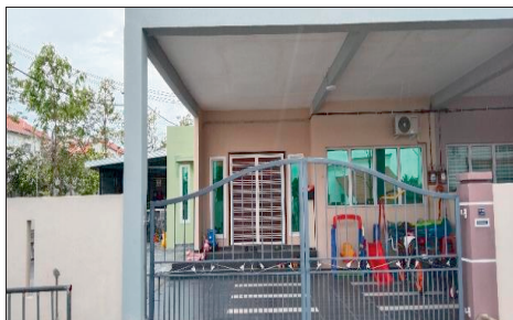
Lot 9648 (DT 263), Taman Nuri, Alor Gajah - Pegangan Tidak Dinilai Semula Selepas Siap Ubah Tambah Bangunan (24.03.2021) Sumber: Jabatan Audit Negara
