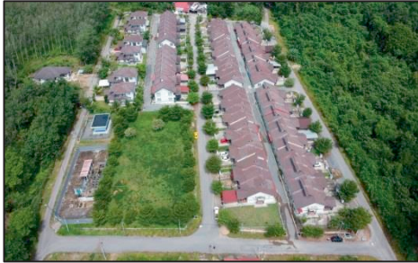
Taman Riyadul Ilmi, Jeli - Projek Pembinaan Perumahan Bercampur di Jeli (12.08.2020) (Sumber: PMBKD)
