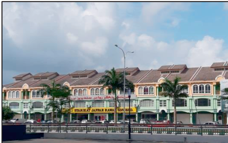
Bandar Baru Tunjong, Kota Bharu - Noble Residence (20.01.2020) (Sumber: Jabatan Audit Negara)
