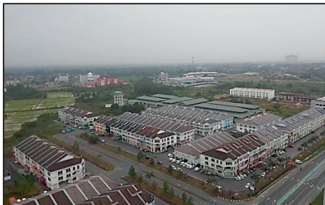
Bandar Baru Tunjong, Kota Bharu - Bangunan Rumah Kedai/Pejabat - Fasa 1 (20.01.2020) (Sumber: Jabatan Audit Negara)
