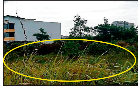
Bandar Baru Tunjong, Kota Bharu - Tapak Prima Lagenda Lifestyle Apartments yang Dihentikan Pembinaan (09.02.2020) (Sumber: Jabatan Audit Negara)
