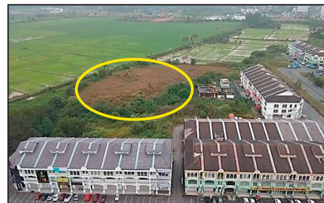
Bandar Baru Tunjong, Kota Bharu - Tapak Bangunan Hotel - Fasa 2C (20.01.2020) (Sumber: Jabatan Audit Negara)
