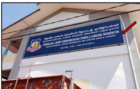
Bangunan Tiga Tingkat, SJK(T) Ladang Semenyih - Papan Tanda yang Telah Dipasang (04.03.2021) (Sumber: Jabatan Audit Negara)
