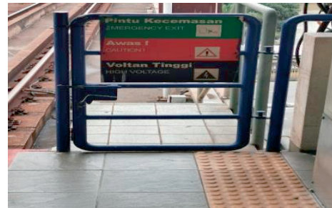
Stesen Sentul Timur – LRT AGL - Pintu kecemasan antara stesen dan landasan yang juga merupakan pintu keselamatan (22.10.2021) (Sumber: Jabatan Audit Negara)
