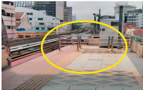
Stesen Masjid Jamek – LRT AGL - Pagar keselamatan yang rendah tidak mampu menghalang pencerobohan (22.10.2021) (Sumber: Jabatan Audit Negara)
