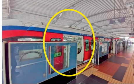
Stesen Titiwangsa – KL Monorail - Reka bentuk screen door tidak sesuai untuk monorel 2 gerabak tetapi sesuai untuk 4 gerabak (22.10.2021) (Sumber: Jabatan Audit Negara)
