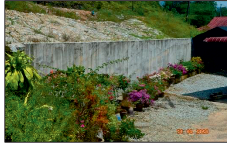
FELCRA Keruak, Hulu Besut - Projek Membina Benteng Hakisan Tebing Jalan Tangki Air (30.06.2020) (Sumber: Jabatan Audit Negara)
