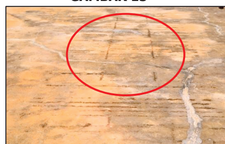
PB Sentral - Tetulang Besi Timbul Pada Permukaan Bumbung (17.02.2021) (Sumber: Jabatan Audit Negara)
