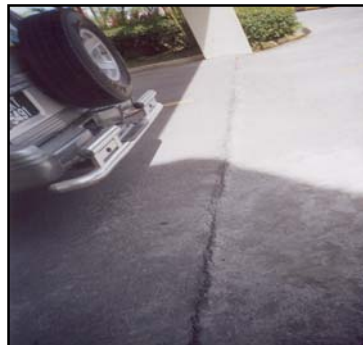
Pemendapan Tanah Di Laluan Utama Bangunan
