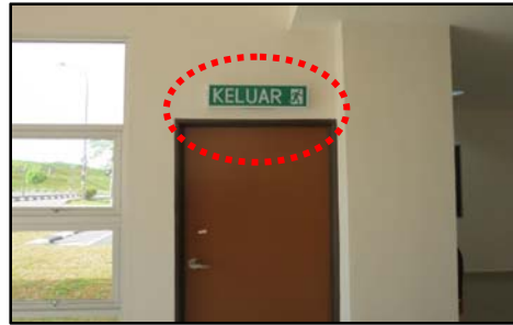
Lobi Aras Bawah, Bangunan COT Seni Kreatif, PIS, Pasir Gudang, Johor - Papan Tanda Untuk Lampu "KELUAR" Tidak Menyala (25.08.2014)
