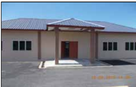
PPPn Selangor Dewan Orang Ramai Di Taman Telipot, Bukit Sentosa 3 - Pandangan Hadapan Dewan (11.03.2015)
