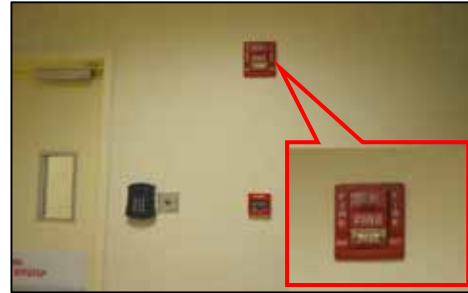
Koridor sebelah RT204 (Koridor 6) - Butiran Jenis Sistem Pencegahan Kebakaran Di Lukisan Dan Fizikal Adalah Berbeza (28.10.2014)
