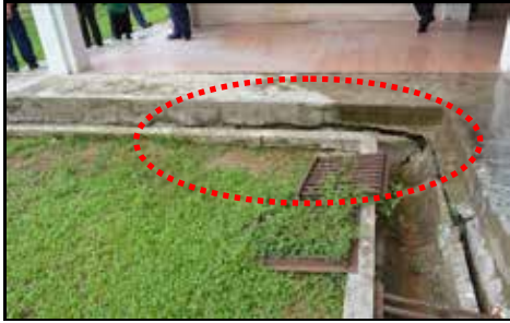
IPG Gaya, Kota Kinabalu, Sabah - Longkang Yang Telah Retak Di Asrama Lelaki (02.12.2014)
