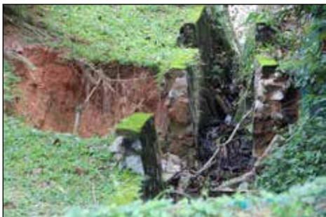
IPG Raja Melewar, Seremban, Negeri Sembilan - Tanah Runtuh Di Cerun Bukit Di Pintu Masuk Kedua IPG (13.11.2014)
