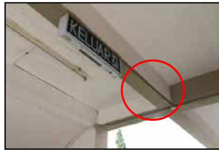
SMK Kinarut - Pembaikan Telah Dijalankan Dengan Menggunakan Cement Grout (27.12.2014)
