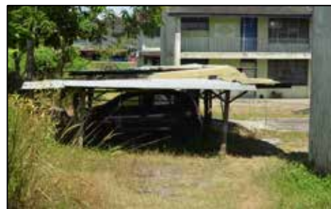
Blok G, Kwarters DCA Johor Bahru - Tambahan Parkir Di Unit Kwarters (10.09.2014)
