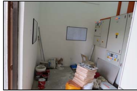
Bilik MSB, Bangunan COT Seni Kreatif, PIS, Pasir Gudang, Johor - Alat Pemadam Api Dan Carta Arahkan Rawatan Renjatan Elektrik Tidak Dilekatkan Di Permukaan Dinding Dalam Bilik Suis Utama (25.08.2014)
