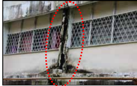
IPG Gaya, Kota Kinabalu, Sabah - Dinding Yang Telah Retak Di Asrama Perempuan (02.12.2014)
