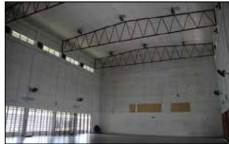
IPG Raja Melewar, Seremban, Negeri Sembilan - Elektrik Trip Di Dewan Badminton (13.11.2014)
