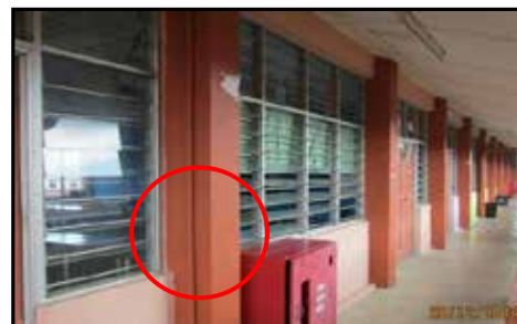
SMK Datuk Panglima Abdullah - Pembaikan Keretakan Bukan Struktur Yang Dibuat Dengan Menampal Keretakan Dengan Lepaan Baru Dan Mengecat Semula (28.12.2014)
