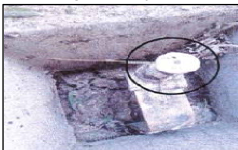
Bangunan COT Marin, PUO, Ipoh, Perak - Penyambungan Pada Earth Electrode Menggunakan Clamp Dan Telah Menggunakan Kaedah Exothermic (23.02.2015) (Sumber: KPM)
