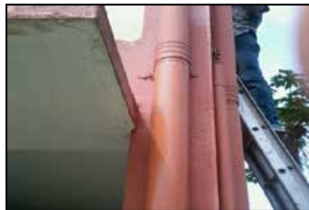
SMK Datuk Panglima Abdullah - Rain Water Downpipes Telah Dibaiki Dan Disambungkan Dengan Kemas (29.12.2014)
