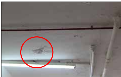
SMK Kinarut - Kerja Kemas Soffit Slab Di Tandas Asrama Puteri Tidak Memuaskan (24.06.2014)
