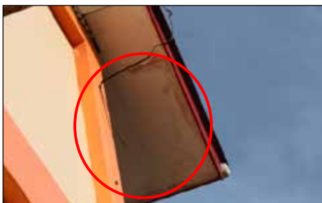
SMK Putatan - Kesan Resapan Air Pada Siling Luar Di Asrama Puteri (24.6.2014)
