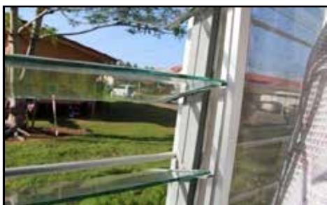
SMK Datuk Panglima Abdullah - Mosquito Netting Yang Dipasang Di Rumah Guru Menyukarkan Cermin Tingkap Dibuka (22.06.2014)
