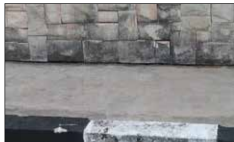
Hotel Seri Malaysia Kangar - Keadaan Lantai Yang Kotor Di Kawasan Luar Dewan Seri Anggerik 1, 2 & 3 Telah Dibersihkan (29.04.2015)
