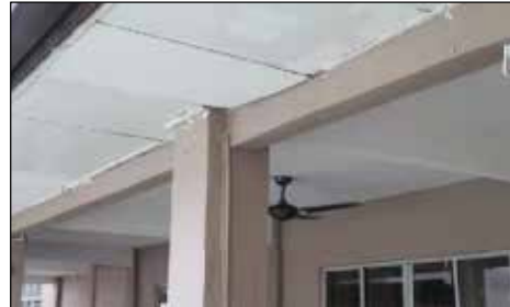
Hotel Seri Malaysia, Bayan Baru, Pulau Pinang - Siling Berlubang Di Luar Café House Telah Di Baik Pulih (29.04.2015)
