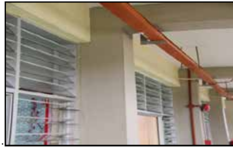
SMK Kinarut - Pembaikan Dilaksanakan Dengan Membuat Lepaan Semula Dan Mengecat Semula (27.12.2014)
