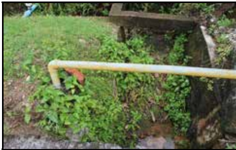
IPG Gaya, Kota Kinabalu, Sabah - Pokok Kecil Yang Tidak Dibersihkan Di Dalam Longkang Di Asrama Perempuan (02.12.2014)
