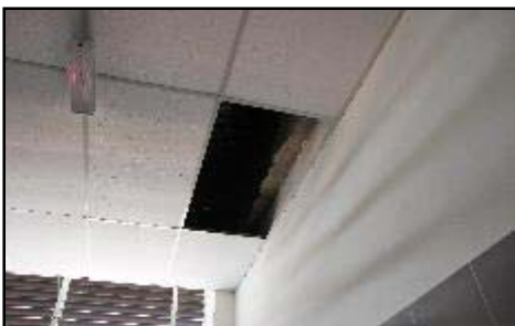
Tandas Wanita, Aras 1, Bangunan COT Seni Reka Kreatif, PIS, Pasir Gudang, Johor - Siling Terbuka Akibat Tiupan Angin Kencang (25.08.2014)
