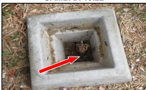
Bangunan COT Marin, PUO, Ipoh, Perak - Penyambungan Pada Earth Electrode Menggunakan Clamp Dan Tidak Menggunakan Kaedah Exothermic Welding (11.08.2014)
