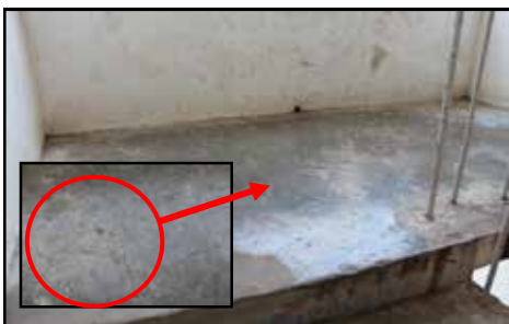
SMK Kinarut - Rekahan Simen Pada Permukaan Tangga Di Asrama Puteri (24.06.2014)
