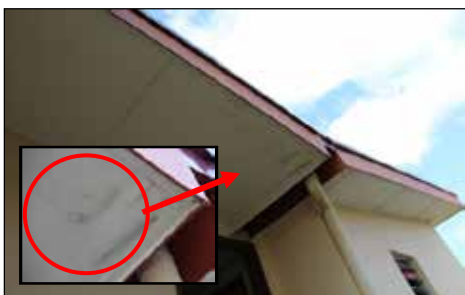
SMK Datuk Panglima Abdullah - Kesan Resapan Air Pada Siling Luar Di Rumah Guru 2 (22.6.2014)
