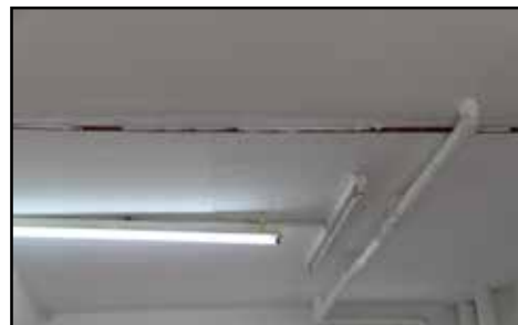
SMK Kinarut - Pembaikan Dijalankan Dengan Kaedah Cut & Patch Menggunakan Cement Grout (27.12.2014)
