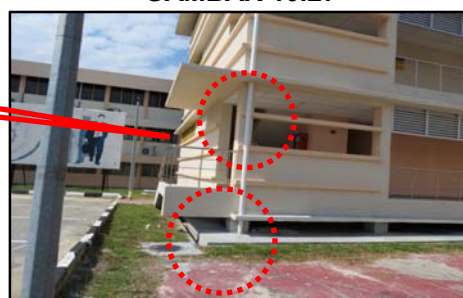
Bangunan COT Marin, PUO, Ipoh, Perak - Kedudukan Test Point Dan Earth Chamber Untuk Sistem Perlindungan Kilat Tidak Dapat Ditemui Seperti Dalam Lukisan (11.08.2014)
