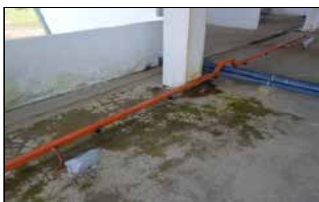
KMS Negeri Sembilan - Kesan Lembapan Dan Lumut Pada Permukaan Lantai Akibat Limpahan Air Menitis Dari Bumbung (14.08.2014)
