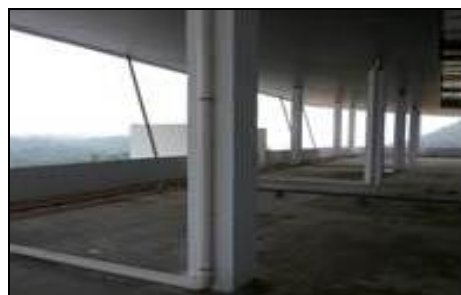
KMS Negeri Sembilan - Keadaan Tiang Yang Telah Dibaiki/Dicat Baru (Oktober 2014)
