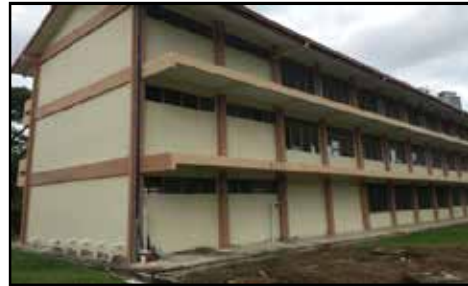
SMK Bandaraya - Kesan Resapan Air Di Belakang Blok Asrama Putera Telah Dibaik Pulih (26.12.2014)
