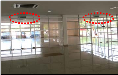
Lobi Aras Bawah, Bangunan COT Seni Kreatif, PIS, Pasir Gudang, Johor - Papan Tanda Untuk Lampu "KELUAR" Tidak Menyala (25.08.2014)
