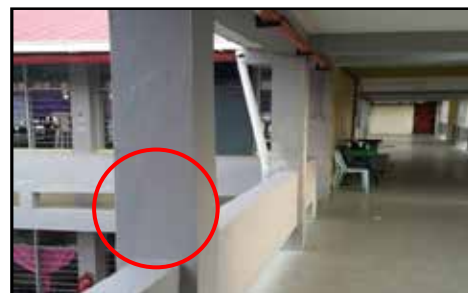
SMK Putatan - Pembaikan Keretakan Yang Bukan Struktur Dibuat Dengan Menampal Keretakan Dengan Lepaan Baru Dan Mengecat Semula (29.12.2014)
