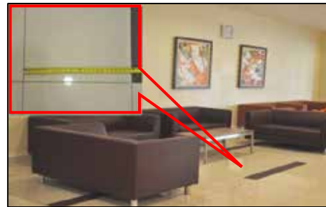
Lobi Radioterapi Dan Onkologi (RT136) - Kemasan Lantai Di Lukisan (Homogeneous Tiles) Berbeza Dengan Sebenar (Homogeneous Tiles Polish) (27.10.2014)
