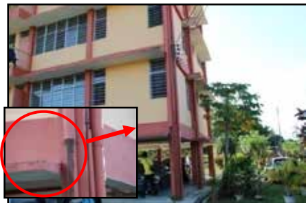
SMK Datuk Panglima Abdullah - Rain Water Downpipes Tidak Dipasang Sempurna Dan Kesan Aliran Air Pada Sambungan Paip Di Flat Guru (22.06.2014)
