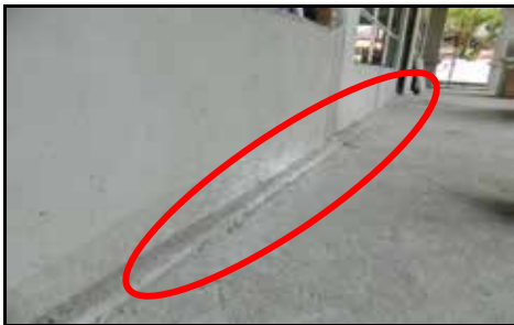
KMSN Pulau Pinang - Keretakan Pada Dinding Laluan Lobi Balai Polis (11.09.2014)
