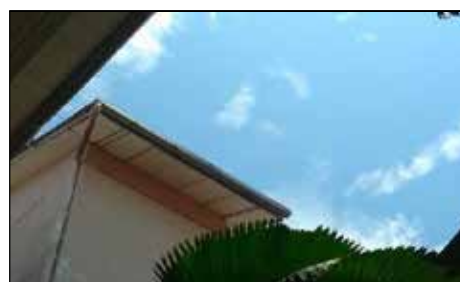
Hotel Seri Malaysia Ipoh - Siling Menara Telah Di Baik Pulih (05.05.2015)
