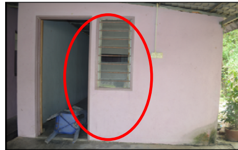
PPPn Selangor - Daun Pintu Hilang Dan Tingkap Bilik Utiliti Telah Rosak Tidak Diperbaiki (22.10.2014)
