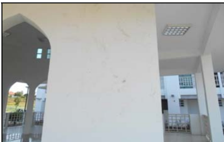
KMS Negeri Sembilan - Kesan Resapan Air Pada Dinding Surau Serta Tindakan Pembaikan Telah Diambil (22.04.2015)
