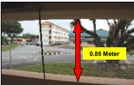
Tangga Sebelah Kanan, Bangunan COT Perkapalan PUO, Ipoh, Perak - Jarak Ruang Terbuka ialah 0.85 Meter (15.08.2014)
