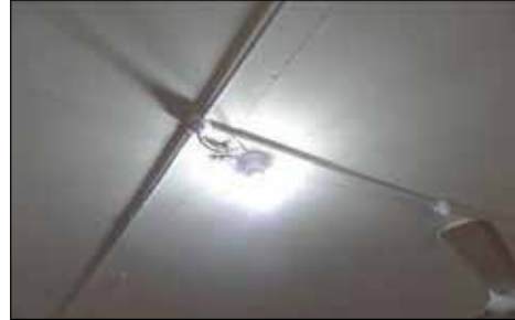
Rumah Dok, Miri - Bekalan Elektrik Telah Digunakan (01.10.2014)
