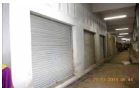
Majlis Perbandaran Muar Menaiktaraf Pasar Awam, Muar Dan Pembinaan 3 Unit Kedai Di Dalam Pasar - 3 Unit Kedai Tersebut Belum Beroperasi (21.12.2014)
