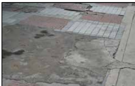
Jalan Chow Kit - Kerja Melepai Semula Permukaan Tidak Kemas (21.10.2014)
