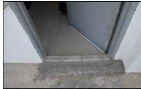
KMS Negeri Sembilan - Binaan Penghadang Air Hujan Untuk Mengelakkan Saliran Air Ke Kawasan Pejabat Lain (14.08.2014)
