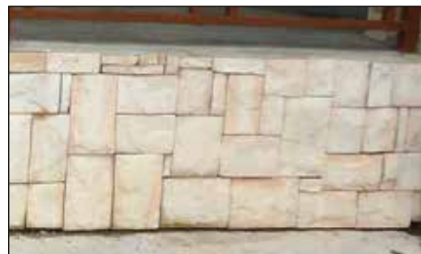
Hotel Seri Malaysia, Kangar - Kepingan Jubin Telah Tercabut Di Hadapan Dewan Seri Anggerik Telah Di Baik Pulih (29.04.2015)
