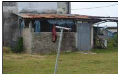
Unit G019, Kwarters DCA Langkawi - Tambahan Struktur/Ruang Pada Bahagian Belakang Kwarters (23.07.2014)
