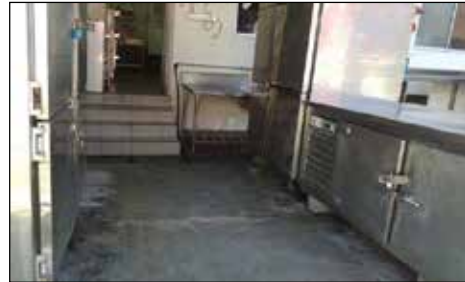
Hotel Seri Malaysia Kuala Terengganu - Lantai Dapur Yang Telah Dibersihkan (28.04.2015)
