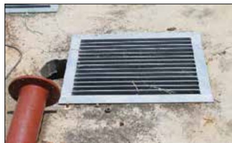
Hotel Seri Malaysia Ipoh - Lubang Penutup Pembetulan Sudah Reput Dan Berkarat Telah Diganti (28.04.2015)
