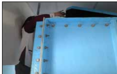
KMSN Kelantan - Laluan Penyenggaraan Di Antara Tangki Air Dan Dinding Yang Sempit (08.10.2013)
