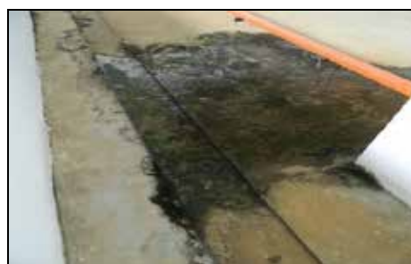
KMS Negeri Sembilan - Kesan Lembapan Dan Lumut Pada Permukaan Lantai Akibat Limpahan Air Menitis Dari Bumbung (14.08.2014)
