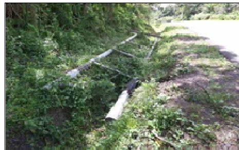
Sepanjang Jalan Sibul-Bintulu (Batu 52 – Batu 62) - Projek Lewat Jadual - Kabel Elektrik Belum Dipasang Dan Tiang Elektrik Belum Didirikan (23.12.2014)
