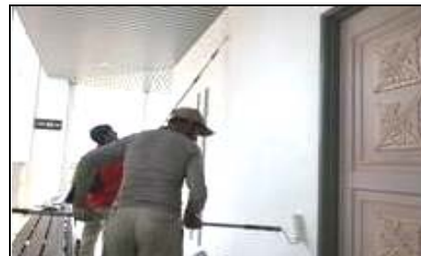
KMS Negeri Sembilan - Kerja-Kerja Mengecat Semula Dinding Telah Diambil Tindakan (Oktober 2014)
