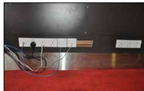
WJ209 (Nurse Station) - Contoh Soket Di Lukisan (7 Soket) Berbeza Dengan Fizikal (6 Soket) (27.10.2014)
