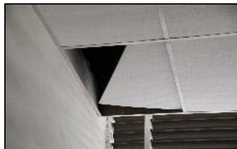
Tandas Wanita, Aras 1, Bangunan COT Seni Reka Kreatif, PIS, Pasir Gudang, Johor - Siling Terbuka Akibat Tiupan Angin Kencang (25.08.2014)
