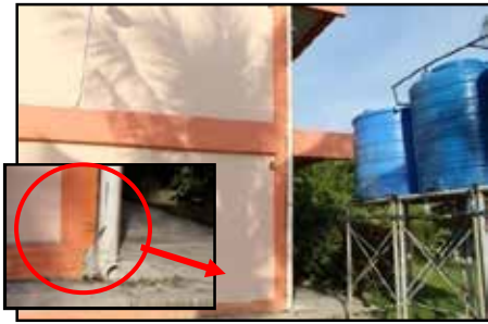
SMK Putatan - Kerja Pemasangan Rain Water Downpipes Di Asrama Lelaki Yang Tidak Sempurna (24.06.2014)
