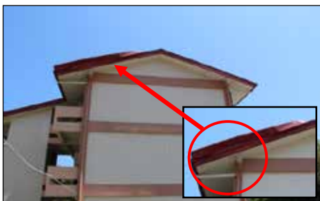
SMK Bandaraya - Kemasan Bumbung Tertanggal Di Asrama Putera Belum Dibaiki (25.06.2014)
