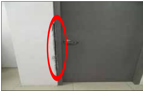
KMS Negeri Sembilan - Keadaan Dinding Pintu Renggang Dan Tindakan Pembaikan Telah Diambil (14.08.2014 & 22.04.2015)
