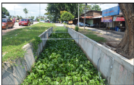
PPP Selangor Menaiktaraf Longkang Tanah Ke Longkang Konkrit Serta Kerja-Kerja Berkaitan Menaiktaraf Longkang Di Pekan Di Pekan Sungai Haji Dorani, Sungai Besar. - Penyenggaraan Tidak Dilakukan Oleh Pihak PBT Kerana Tiada Penyerahan Projek Kepada PBT (24.10.2014)
