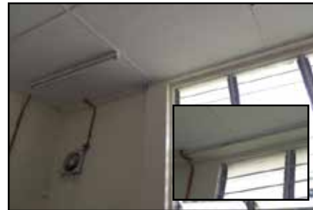
SMK Bandaraya - Pembaikan Dijalankan Dengan Kaedah Cut & Patch Menggunakan Cement Grout (26.12.2014)
