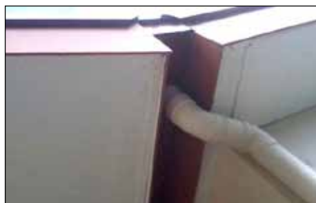
SMK Datuk Panglima Abdullah - Bumbung Telah Dibaiki Bagi Mengelakkan Resapan Air (28.12.2014)
