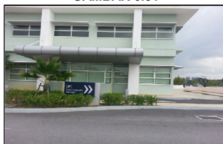
Pintu Masuk Parkir Kakitangan - Kerja-kerja Memangkas Telah Dilakukan Pada 02.12.2014 Selepas Teguran Audit (Sumber: Jabatan Kerja Raya)
