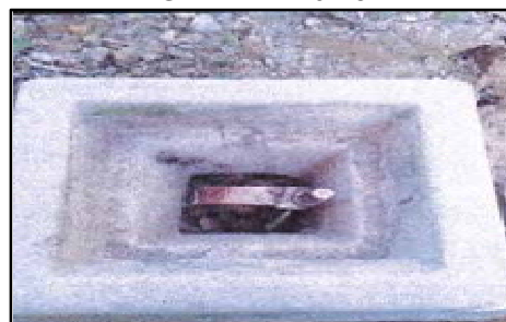
Bangunan COT Marin, PUO, Ipoh, Perak - Penyambungan Pada Earth Electrode Menggunakan Clamp Dan Telah Menggunakan Kaedah Exothermic (23.02.2015) (Sumber: KPM)
