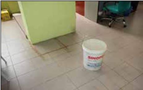
IPG Raja Melewar, Seremban, Negeri Sembilan - Bekas Tadahan Air Terpaksa Disediakan Akibat Titisan Air Apabila Hujan Di Bangunan Astaka (13.11.2014)
