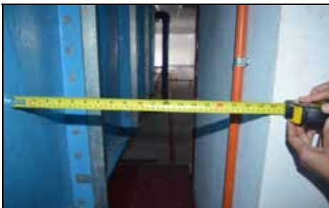
KMSN Kelantan - Laluan Penyenggaraan Di Antara Tangki Air Dan Dinding Yang Sempit (08.10.2013)
