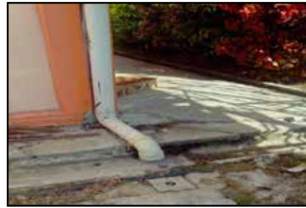
SMK Putatan - Rain Water Downpipes Disambung Dan Dialirkan Ke Parit (29.12.2014)
