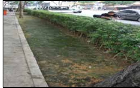
Jalan Ipoh - Keadaan Landskap Yang Tidak Memuaskan (21.10.2014)
