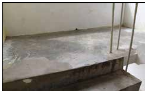
SMK Kinarut - Pembaikan Telah Dilaksanakan Dengan Menjalankan Rescreeding Pada Bahagian Yang Rosak (27.12.2014)
