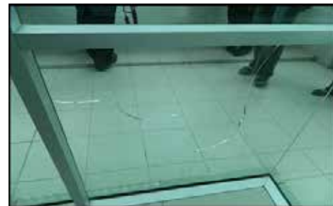
KMS Negeri Sembilan - Keretakan Pada Struktur Glass Panel (14.08.2014)
