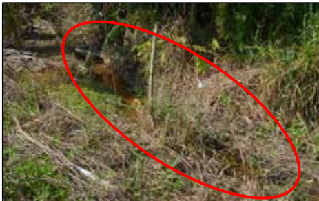
Kuarters DCA Kuching - Sistem Perparitan Tidak Sempurna Menyebabkan Air Bertakung (21.08.2014)
