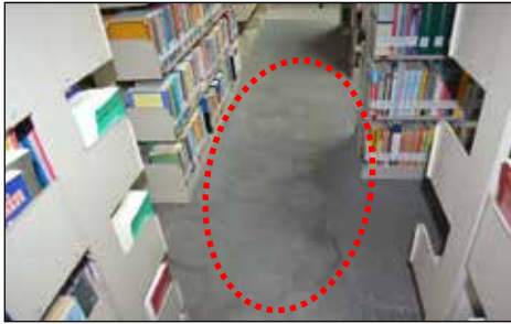
IPG Gaya, Kota Kinabalu, Sabah - Kesan Resapan Air Di Permaidani Akibat Kebocoran Atap Di Perpustakaan (02.12.2014)
