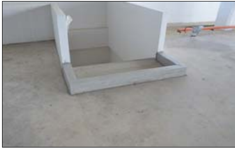
KMS Negeri Sembilan - Binaan Penghadang Air Hujan Untuk Mengelakkan Saliran Air Ke Kawasan Pejabat Lain (14.08.2014)
