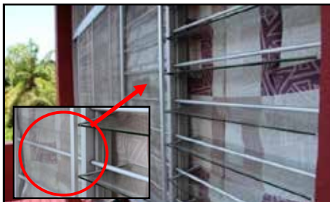
SMK Datuk Panglima Abdullah - Jarak Mosquito Netting Yang Rapat Dengan Cermin Tingkap Menyebabkan Ia Mudah Rosak (22.06.2014)
