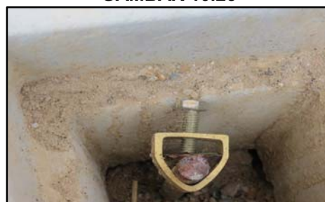
Bangunan COT Marin, PUO, Ipoh, Perak - Penyambungan Pada Earth Electrode Menggunakan Clamp Dan Tidak Menggunakan Kaedah Exothermic Welding (11.08.2014)
