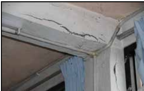
IPG Gaya, Kota Kinabalu, Sabah - Alang dan Siling Yang Telah Retak Di Bangunan Pentadbiran Aras 2 (02.12.2014)
