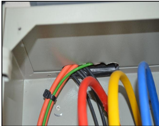
GAMBAR 15.8 Tiada Penebat Bush Pada Bukaannya Masukan Kabel Ke Papan Suis
