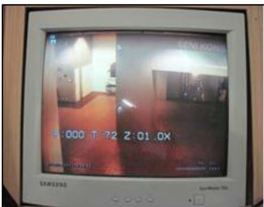
GAMBAR 12.10 Kamera Yang Tidak Memfokus Pada Pintu Utama
