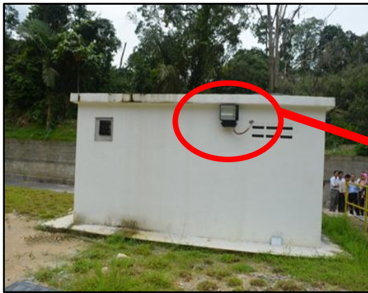
GAMBAR 15.13 Konduit Mudah Lentur Telah Berkarat
