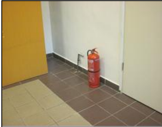
GAMBAR 12.4 Alat Pemadam Api Yang Masih Diletakkan Di Atas Lantai
