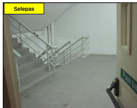
GAMBAR 12.9 Laluan Kecemasan Yang Telah Dibersihkan
