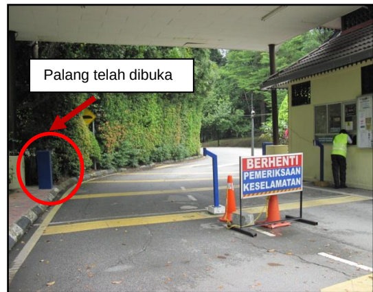
GAMBAR 21.2 Automatic Drop Gate System Tidak Berfungsi Sejak September 2011
