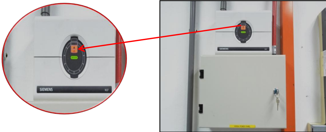
GAMBAR 11.5 Panel Kawalan VESDA Menunjukkan Warna Merah Kerana Habuk Dikesan
