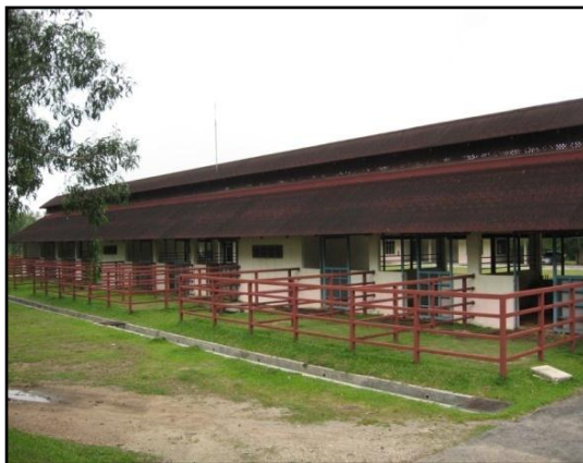
GAMBAR 16.11 Kandang Kuda Baru Tidak Digunakan Sepenuhnya
