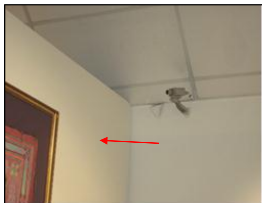
GAMBAR 12.11 Dinding Panel Yang Menghalang Sudut Pengawasan
