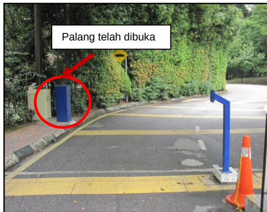
GAMBAR 21.1 Automatic Drop Gate System Tidak Berfungsi Sejak September 2011
