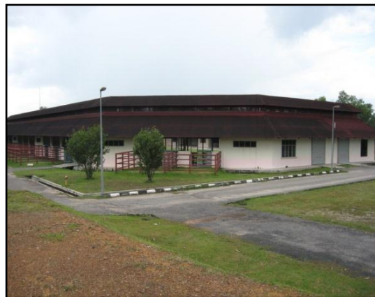
GAMBAR 16.12 Kandang Kuda Baru Tidak Digunakan Sepenuhnya
