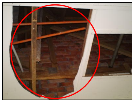
Siling Yang Telah Pecah Di Asrama
