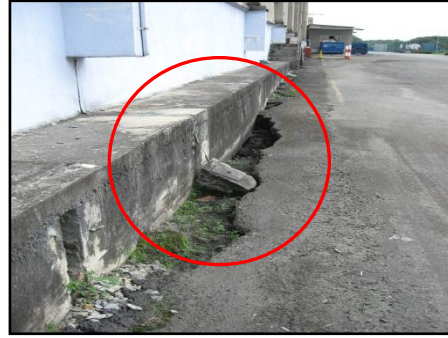
Lubang Terbentuk Kesan Mendapan Jalan
