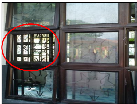
Cermin Tingkap Pecah Di Asrama
