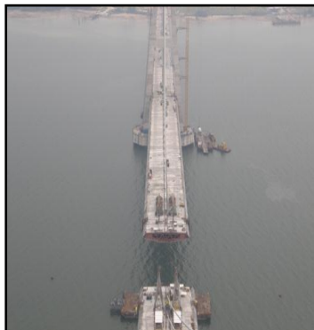
Composite Deck Jambatan Pakej 3B Yang Belum Siap
