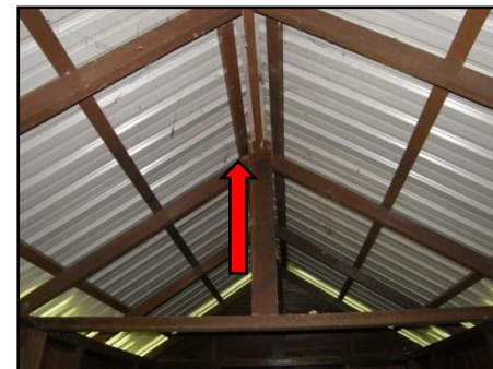
Siling Tidak Dipasang Pada Bumbung Rumah Guru Silat
