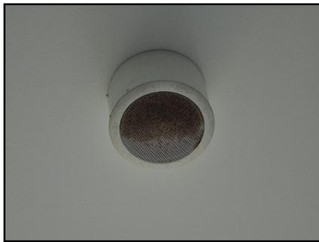
Pembesar Suara Berkarat Di Fakulti Kejuruteraan Elektrik dan Elektronik
