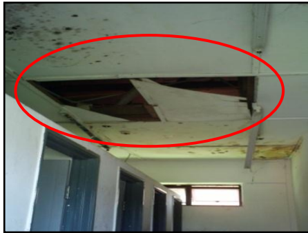
Siling Tandas Yang Pecah Di Asrama
