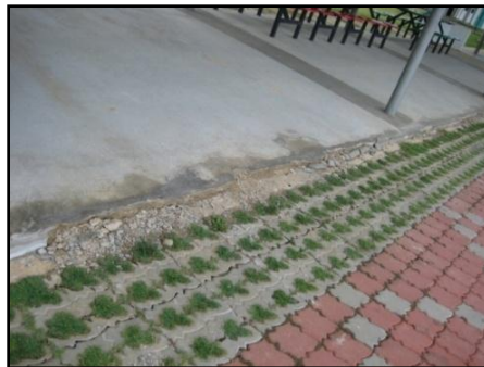
Siar Kaki Pecah Di Bangunan Fakulti Kejuruteraan Elektrik Dan Elektronik
