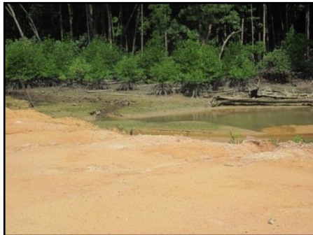
Revetment Protection Belum Dibina Di Pulau Juling
