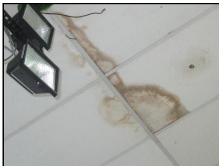
Kesan Resapan Air Di Siling Dewan Serbaguna
