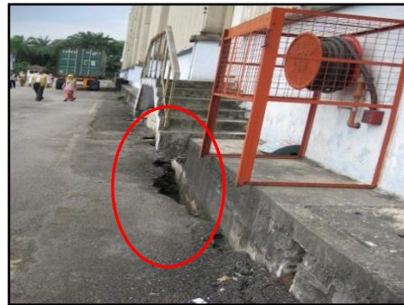
Lubang Kesan Mendapan Yang Menakung Air Ketika Hujan Lebat
