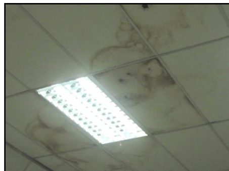
Kesan Resapan Air Di Siling Dewan Serbaguna
