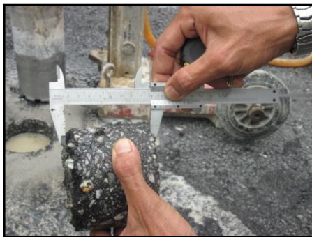
Ujian Coring Kedua Untuk Mengukur Ketebalan Turapan DBM
