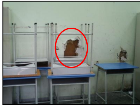
Dinding Pecah Di Dalam Kelas
