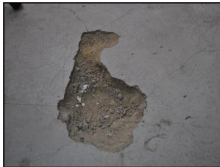
Lantai Simen Yang Pecah Di Bilik Kuliah, Fakulti Kejuruteraan Mekanikal
