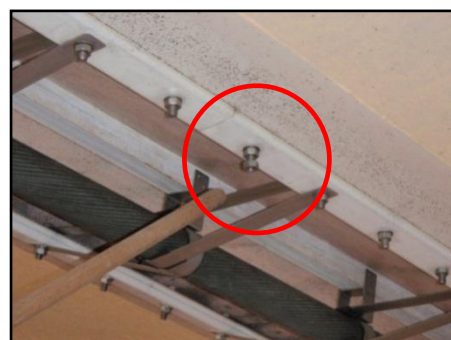
Kawasan Penyambungan Skrus Kabel Telah Berkarat
