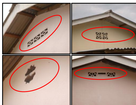
Tingkap Ram Tetap Digantikan Dengan Batu-Bata Lubang Angin
