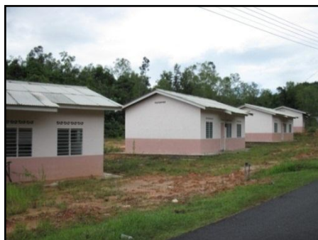
Rumah Bina Baru Di Bukit Besi, Dungun
