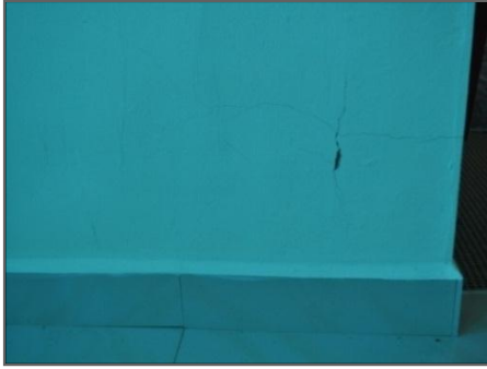
Keretakan Pada Permukaan Dinding Dewan Kuliah Fakulti Kejuruteraan Mekanikal
