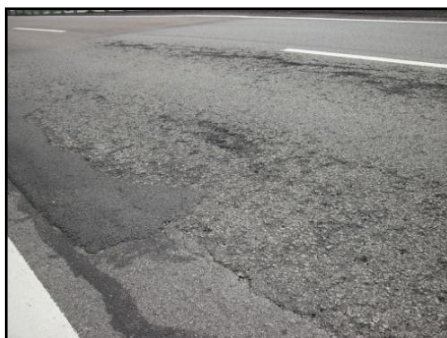
Permukaan Jalan Yang Rosak Di Kilometer 17.8
