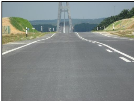
Permukaan Jalan Yang Beralun Di Kilometer 50.3
