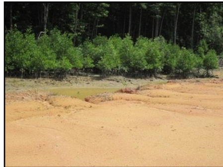
Revetment Protection Belum Dibina Di Pulau Juling
