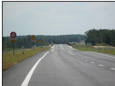
Permukaan Jalan Yang Beralun Di Kilometer 46.5
