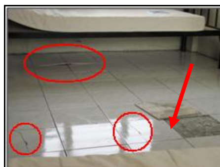
Lantai Pecah Dan Tanggal Di Bilik Asrama 2.4, Blok V11A
