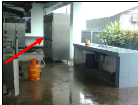
Peralatan Yang Terdedah Kepada Hujan Di Bangunan Gerai
