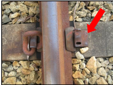
Kehilangan Besi Landasan Di Kawasan Gelang Patah, Johor
