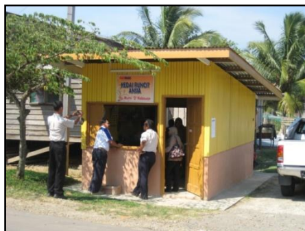
Kedai Yang Telah Dibaik Pulih Di Kampung Murni, Nabawan, Keningau
