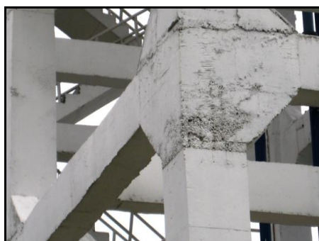
Honeycomb Terbentuk Di Tiang Kerangka EWT
