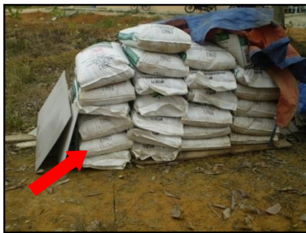
Baja Diletakkan Di Tempat Terbuka Dan Ditutup Dengan Kanvas Di Kampung Sri Paya, Kulai Johor
