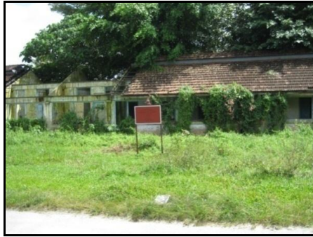
Tanah Tidak Berpagar Di Tanah PAK, Falim, Perak
