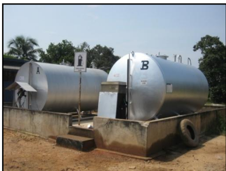
Keadaan Tangki Minyak Petrol dan Diesel Di Hadapan Pejabat Ladang KPSB Kemaman
