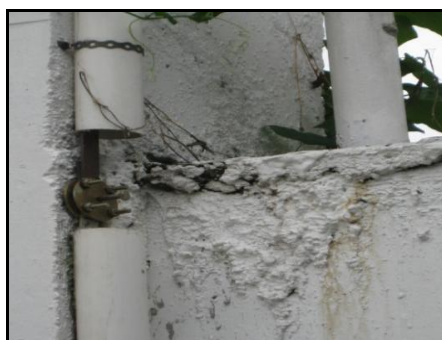
Lebih Simen Tidak Dibuang Daripada Tiang Kerangka
