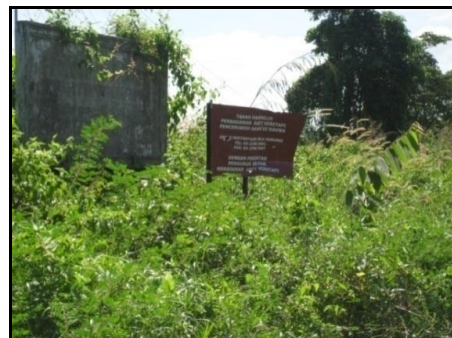
Pemasangan Papan Tanda Tanah Milik PAK Di Tempat Yang Tidak Strategik Di Palekbang, Kelantan
