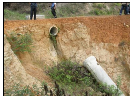
Kerosakan Yang Berlaku Di Pipe Culvert No. 3
