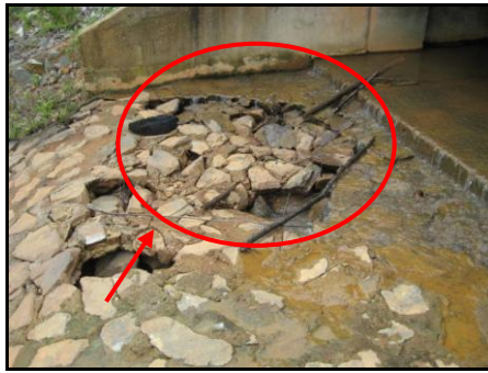
Kerosakan Rubble Pitching Di Empangan 2
