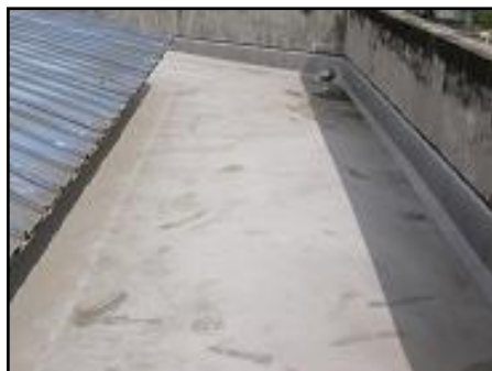
Bumbung Rata - Kerja Membaiki Bumbung Rata Dengan Menyapu Lapisan Kalis Air Di Atas Permukaan Bumbung Konkrit
