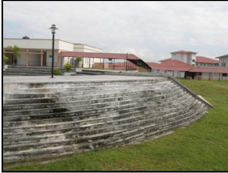
Granolithic Finish Di Amphitheatre Tidak Siap Dan Tidak Sempurna
