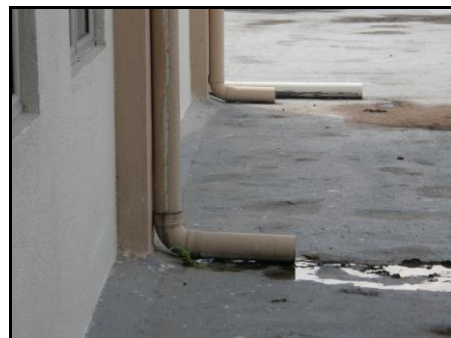
Air Bertakung Di Permukaan Bumbung
