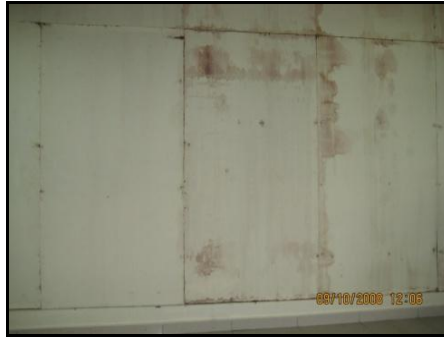
Pembinaan Dinding Aras 2, Pusat Latihan Khas Gimnasium 3 Yang Belum Siap Dan Ditutupi Menggunakan Papan Lapis
