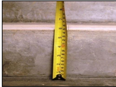
Tinggi Anak Tangga Di Bangunan Akademik Hanya Berukuran 145mm
