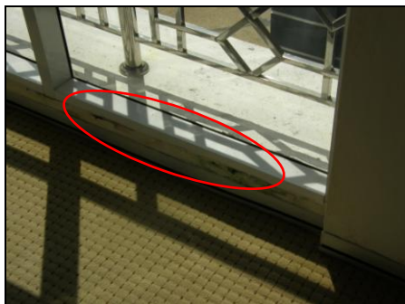
Kesan Resapan Air Dari Dinding Kaca
