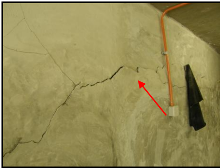
Keretakan Serius Di Dinding Di Dalam Bilik Stor
