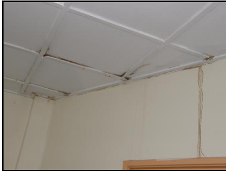
Kesan Resapan Air Di Siling Dan Dinding
