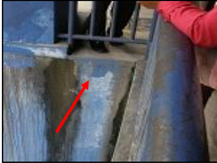
Bahagian Belakang Aras Bawah - Kesan Kekotoran Dari Saluran Air Buangan
