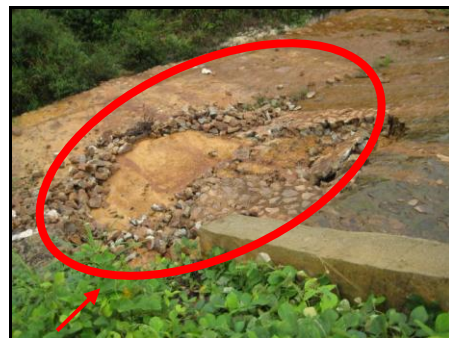
Kerosakan Rubble Pitching Di Empangan 1
