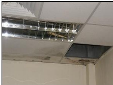
Kesan Resapan Air Di Siling Dan Berhampiran Dengan Lampu
