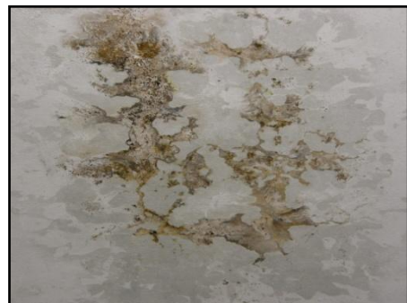
Kesan Karat Yang Merebak Pada Permukaan Konkrit
