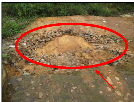
Kerosakan Rubble Pitching Di Empangan 1
