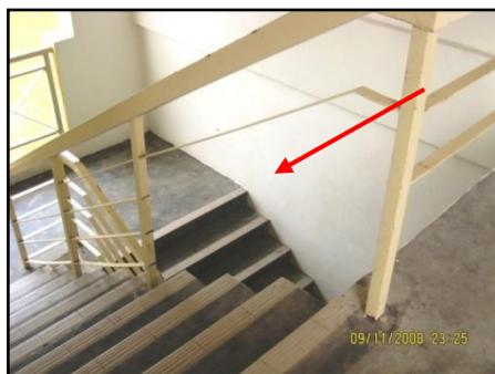
Kerangka Susur Tangga Yang Telah Tertanggal Di Bangunan Akademik
