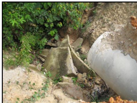
Kerosakan Yang Berlaku Di Pipe Culvert No. 3
