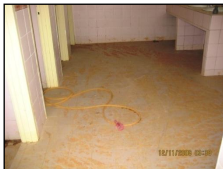
Tanah Merah Yang Masuk Melalui Floor Trap Di Bilik Air Pavilion
