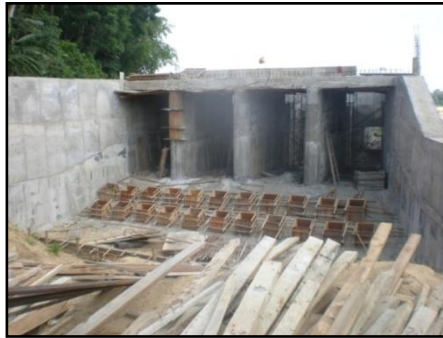
Rumah Pam Air Lemal Baru Yang Masih Dalam Pembinaan
