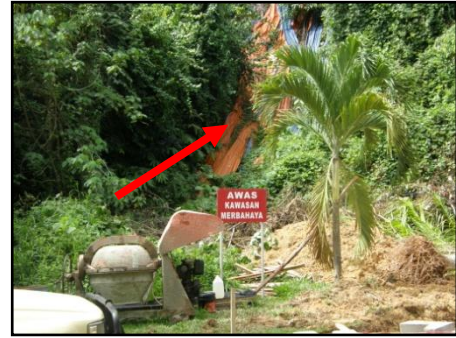
Kawasan Cerun Yang Runtuh Di Lereng Bukit
