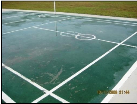
Air Bertakung Di Gelanggang Sepak Takraw
