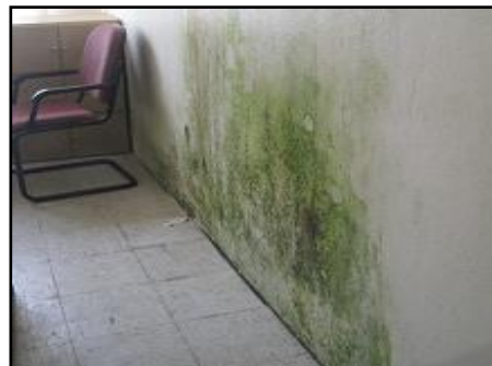
Kesan Resapan Dan Berlumut Di Dinding Bilik Pensyarah
