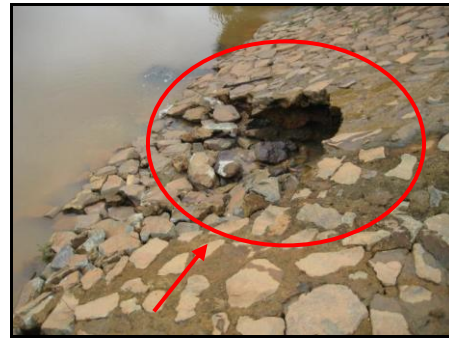
Kerosakan Rubble Pitching Di Empangan 2
