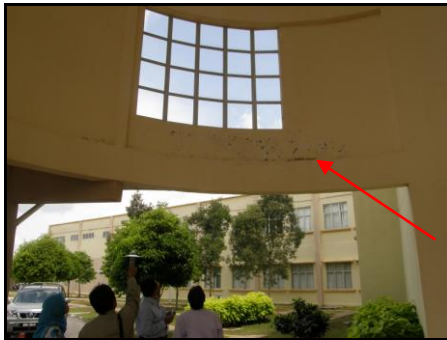
Cat Menggelupas Di Permukaan Luar Dan Dalam Dinding
