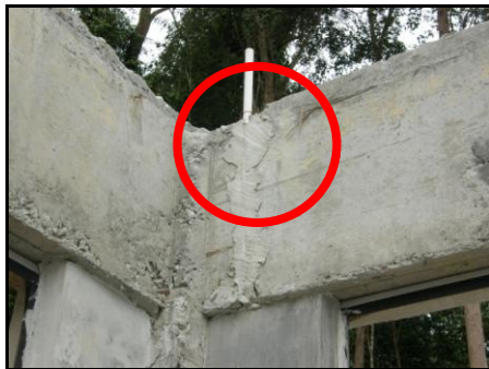
Kesan Tampalan Di Permukaan Rasuk Bumbung
