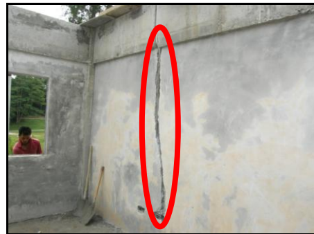
Kesan Potongan Di Permukaan Dinding
