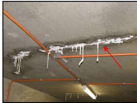
Kesan Resapan Air Di Siling Bilik Stor
