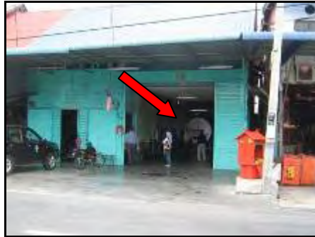
Pandangan Luar Bangunan 145, Jalan Pantai, Kerian, Perak
