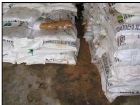
Palet Tidak Digunakan Untuk Melapik Baja Di Stor Simpang Songsang, Temerloh, Pahang
