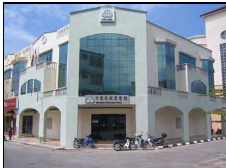
Laluan Orang Kurang Upaya Tidak Disediakan Di Pejabat Cawangan PERKESO Taiping, Perak
