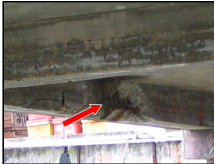
Struktur Jeti Yang Retak
