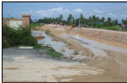
Jalan Masuk Ke Kompleks Masih Dalam Pembinaan
