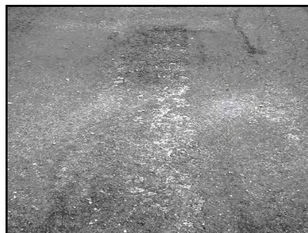
Kerja Penurapan Jalan Yang Tidak Rata
