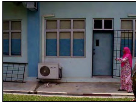
Tingkap Tidak Dipasang Jeriji di Pusat Penyelidikan Teknologi Makanan Serdang
