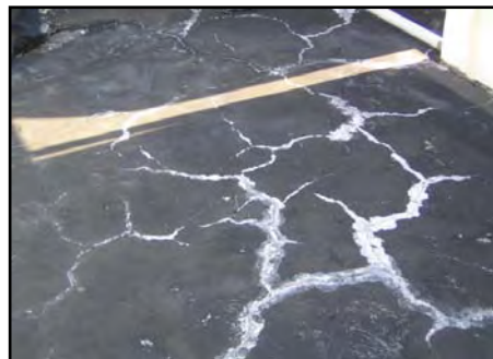
Permukaan Kalis Air Retak
