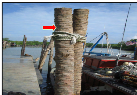
Batang Kelapa Digunakan Sebagai Fender
