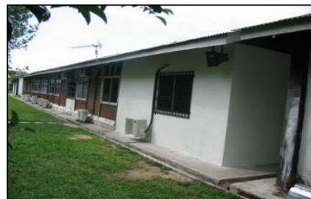
Pangkalan TUDM Kuantan - Kerja Menaik Taraf Sebahagian Bangunan Pejabat Pegawai Memerintah
