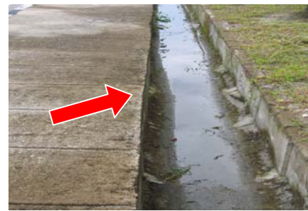
Longkang Yang Dibina Tidak Mengikut Gradian Yang Ditetapkan iaitu 1:60mm Menyebabkan Air Bertakung Di Dalam Longkang.
