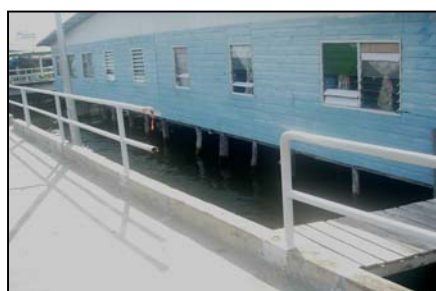
Handrail Laluan Pejalan Kaki Utama Rumah Dipotong
