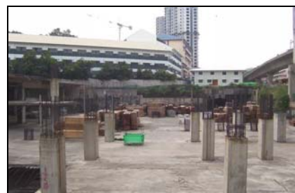
Sebahagian Kerja Cerucuk Besi Yang Telah Dilakukan
