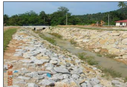
Kuala Teriang, Pulau Langkawi - Kerja Pelurusan Sungai Dan Penstabilan Cerun Yang Disiapkan Oleh Syarikat Bonabase Corporation Sdn. Bhd.
