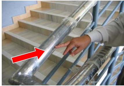
Besi Tahan Karat Yang Dipasang Pada Handrail Telah Berkarat Walaupun Tempoh Tanggungan Kecacatan Belum Tamat
