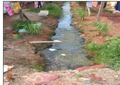
Kota Kuala Muda, Kedah - Sistem Saliran Kurang Memuaskan Menyebabkan Parit Tersumbat Di Sekeliling Rumah Transit
