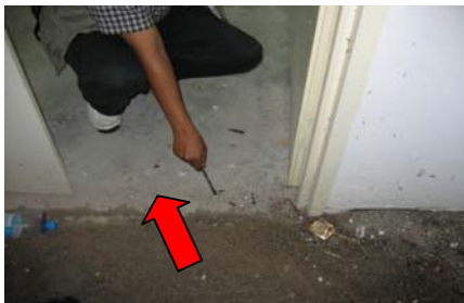
Tidak Ada Drop Di Antara Jalan Dan Bilik Stor Makanan Di Tingkat Bawah Blok Pentadbiran
