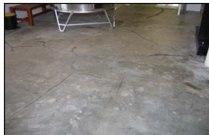
Hospital Setiu - Kemasan Lantai Di Pintu Masuk Jabatan Sajian Tidak Memuaskan
