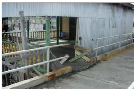
Handrail Laluan Pejalan Kaki Utama Rumah Dipotong
