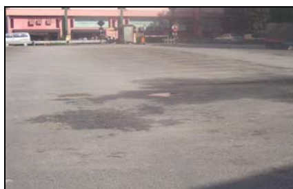
Tempat Letak Kereta DBKL Lot 1248 Dan 12534, Jalan Sultan Ismail - Kurang Kenderaan Di Tapak
