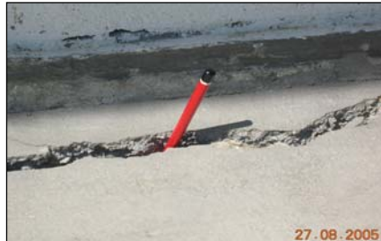
Tanjung Bungah, Pulau Pinang (Fasa I) - Keretakan Yang Berlaku Di Apron Di Rumah Transit
