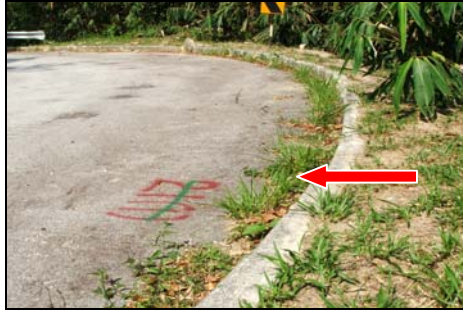
Kilometer 5.24 - Berlaku Rekanan Jalan Di Cerun Yang Dikambus Dan Rumput-rumput Tidak Tumbuh Dengan Sempurna
