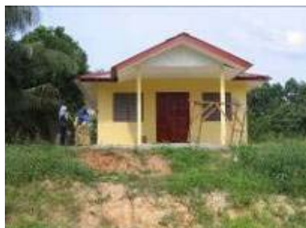
Pusat Sumber, Felcra Sri Makmur, Pahang - Bangunan Yang Telah Disiapkan Tidak Diguna Kerana Jalan Masuk Tidak Dibina
