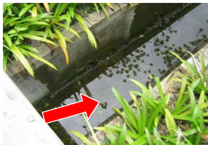
Longkang Yang Dibina Tidak Mengikut Gradian Yang Ditetapkan iaitu 1:60mm Menyebabkan Air Bertakung Di Dalam Longkang.
