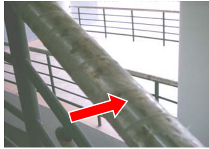
Besi Tahan Karat Yang Dipasang Pada Handrail Telah Berkarat Walaupun Tempoh Tanggungan Kecacatan Belum Tamat
