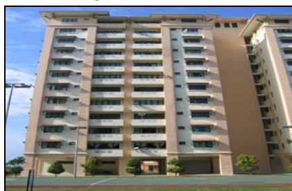
Hospital Temerloh - Grill Tidak Dipasang Pada Tingkap Di Kuarters
