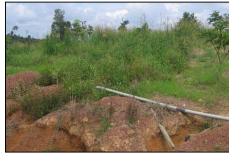
Tapak Projek Charuk Puting, Pahang - Parit Rosak Akibat Hakisan
