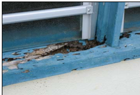
SMT Sejingkat - Bingkai Tingkap Di Bengkel Dimakan Anai-Anai
