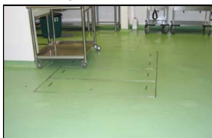
Hospital Setiu - Kedudukan Grease Trap Di Dalam Jabatan Sajian
