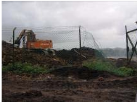
Kilang Kelapa Sawit, Sg. Melikai, Johor - Longgokan Bahan Sisa Sawit Yang Dilupuskan Secara Land Field
