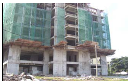
Kerja Pembinaan Blok F Sedang Dijalankan
