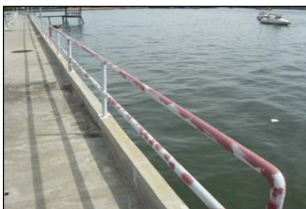
Lapisan Cat Handrail Yang Telah Tertanggal
