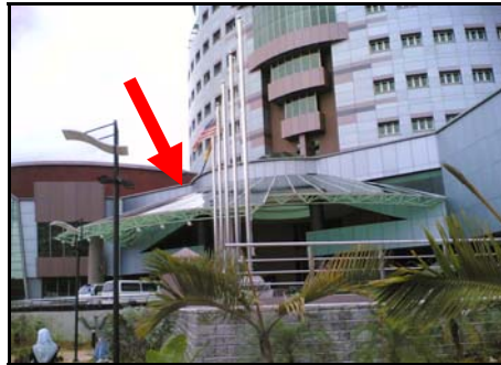
Pembinaan Space Frame Dan Skylight Roof Yang Berbeza Dari Lakaran Asal
