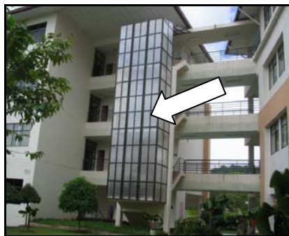
Tangga Yang Dipasang Penghadang Hujan
