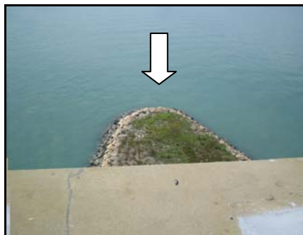
Small Island Dibina Di Bahagian Bawah Jambatan Untuk Memudahkan Pemeriksaan Dan Penyenggaraan
