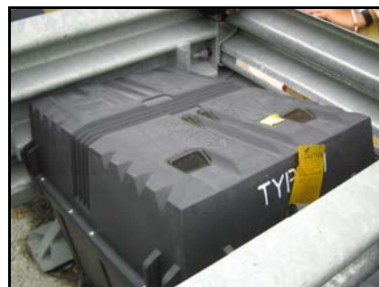
Crash Cushion Dipasang Di Persimpangan Berbahaya Lebuhraya Bagi Mengurangkan Impak Kemalangan Kepada Pemandu
