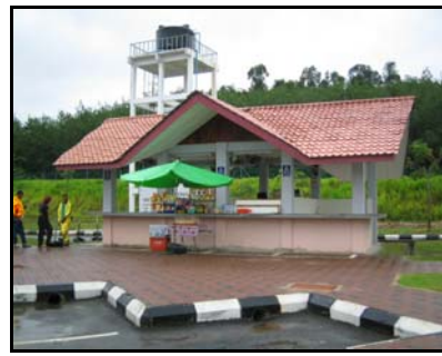
Peniaga Memasang Payung Yang Tidak Dibenarkan
