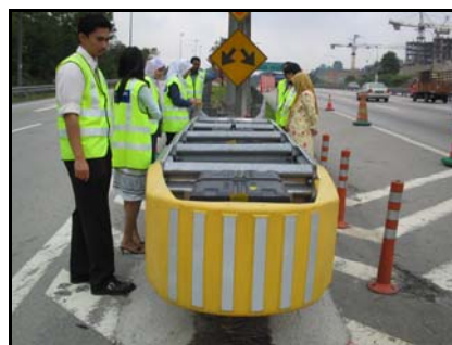
Crash Cushion Dipasang Di Persimpangan Berbahaya Lebuhraya Bagi Mengurangkan Impak Kemalangan Kepada Pemandu
