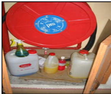
Ruang Menyimpan Hos Bomba Dijadikan Tempat Menyimpan Peralatan Mencuci
