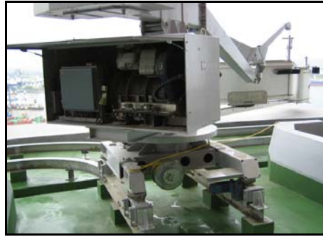
Peralatan Gondola Bagi Tujuan Membersihkan Bahagian Menara Kawalan
