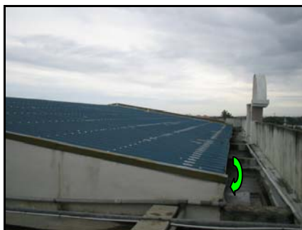
Keadaan Bumbung Dan Saluran Yang Menyebabkan Air Melimpah Masuk Ke Siling Bangunan
