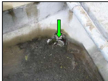
Keadaan Bumbung Dan Saluran Yang Menyebabkan Air Melimpah Masuk Ke Siling Bangunan
