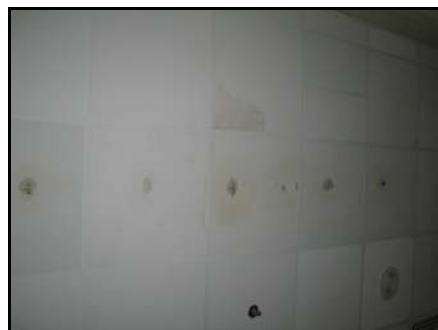
Siling Stor Yang Bocor
