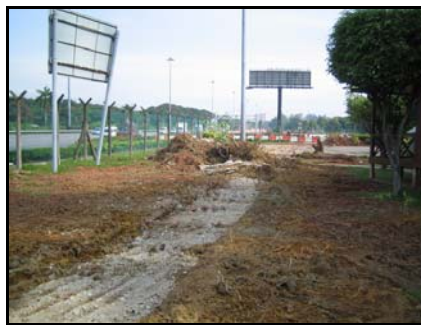
Kerja Pelebaran Jambatan Pulau Pinang Sedang Giat Dijalankan
