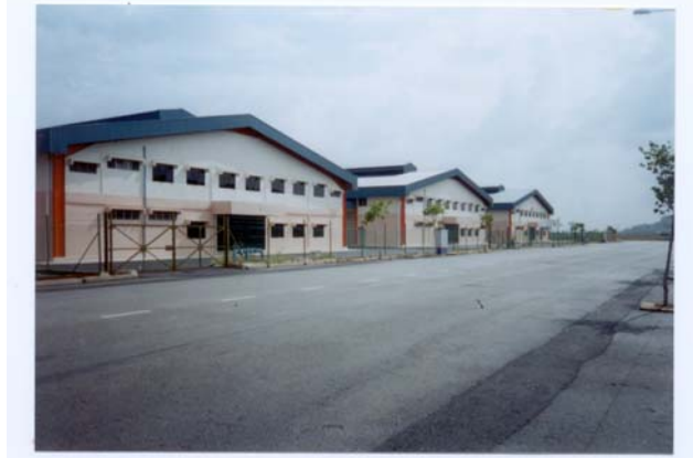
Bangunan Kilang Kawasan Perindustrian Gebeng, Kuantan
