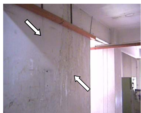
Resapan air di dinding laluan utama
