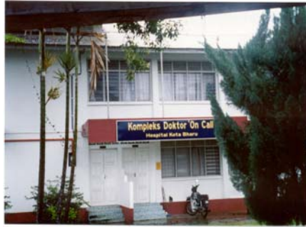
Bekas Bangunan Klinik Lembaga Di Kota Bharu
