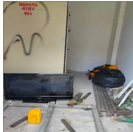
Bilik Suis, Kem 31 RAD Kajang - Tiada Alas Getah di Hadapan Papan Suis (05.12.2019) (Sumber: Jabatan Audit Negara)
