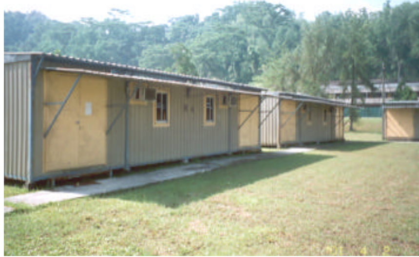
Kontena Digunakan Sebagai Bilik Kuliah
