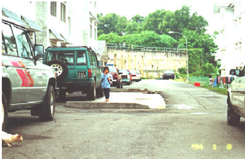
Lokasi : Perumahan PDRM Sri Temenggung, Melaka Keadaan Rumah : Sistem Pembetungan Dan Tangki Septik Rosak Tarikh Siap Dibina : April 1995
