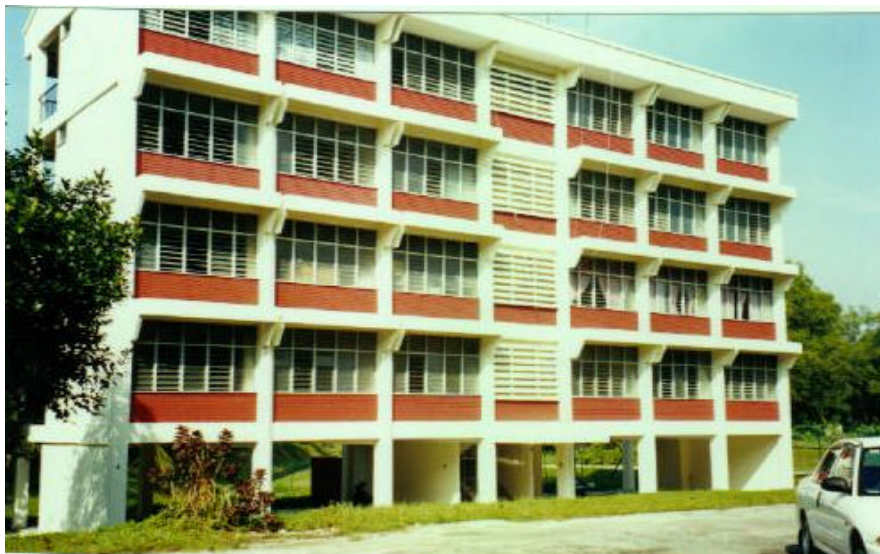
Lokasi : Taman Imigresen Pasir Gudang, Johor Bahru Keadaan Rumah : Rumah Dibaik Pulih Tetapi Tidak Diduduki Sepenuhnya
