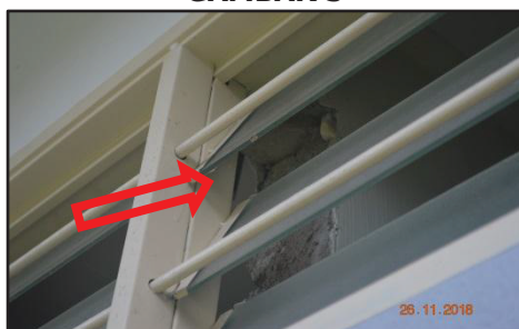
Kg. Gasing, Marang - Kemasan Dinding Tidak Sempurna (26.11.2018)
