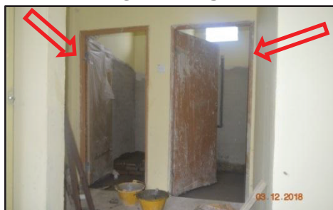
Kg. Durian Mas, Kuala Terengganu - Bingkai Pintu Jenis PVC Digunakan Untuk Pintu Bilik Air (03.12.2018)
