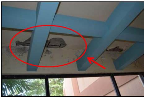
Struktur Bangunan Pecah - Ruang Rehat Blok Garden Wing (23 Julai 2019) (Sumber: Jabatan Audit Negara)
