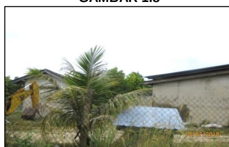
TKPM Rhu Tapai, Setiu - Bangunan Kekal Dibina di Lot 19A (10.07.2018)
