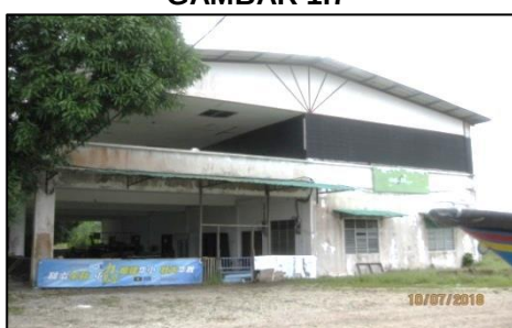
TKPM Rhu Tapai, Setiu - Bangunan Kekal Dibina di Lot 32A (10.07.2018)
