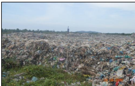
Tapak Pelupusan Sisa Pepejal MDB - Sisa Pepejal di Sel 1 Tidak Ditutup Dengan Tanah (24.04.2018)
