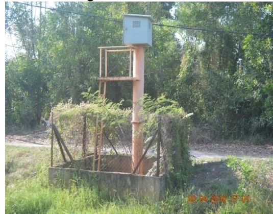
Gambar 1.6 Stesen Siren Yang Tidak Berfungsi
