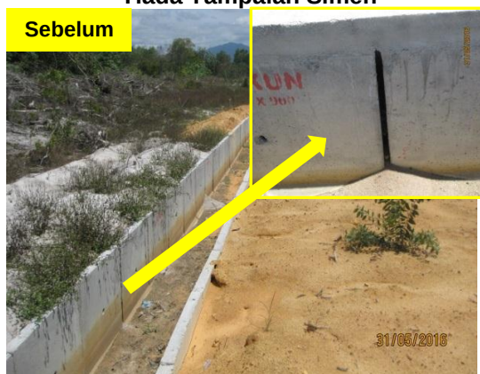
Gambar 3.10 Jarak Antara Longkang Tiada Tampalan Simen
