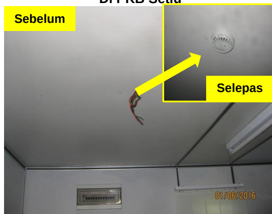
Gambar 3.1 Alat Pengesan Asap Di PKB Setiu
