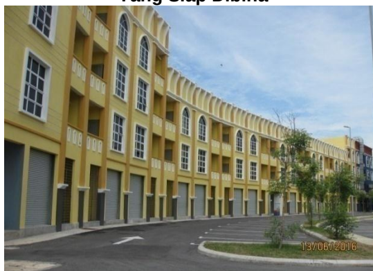
Gambar 4.4 Bangunan Kedai Pejabat Yang Siap Dibina
