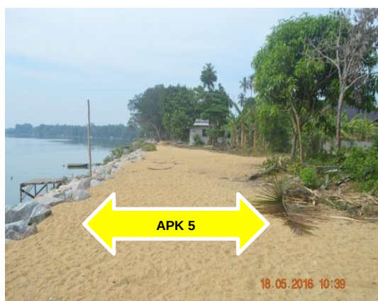
Gambar 1.1 Kerja Tambahan Bagi Projek Pemulihan Dan Membenteng Tebing Kiri Sungai Terengganu Di Kampung Manir, Teluk Menara Dan Beladau Kolam, Kuala Terengganu
