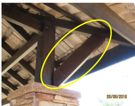
Gambar 3.7 Palang Penahan Telah Dipasang Bagi Menyokong Struktur Atap
