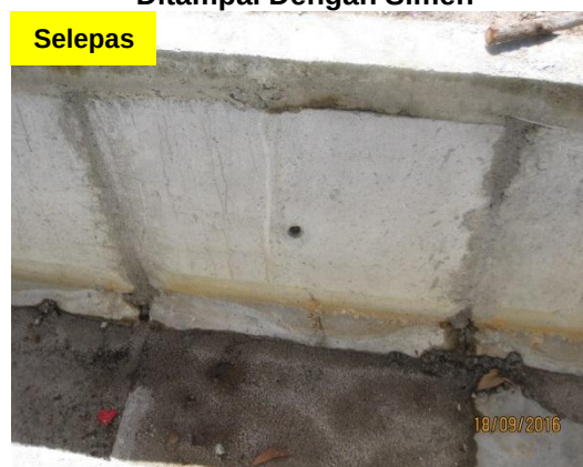
Gambar 3.11 Longkang Yang Telah Ditampal Dengan Simen
