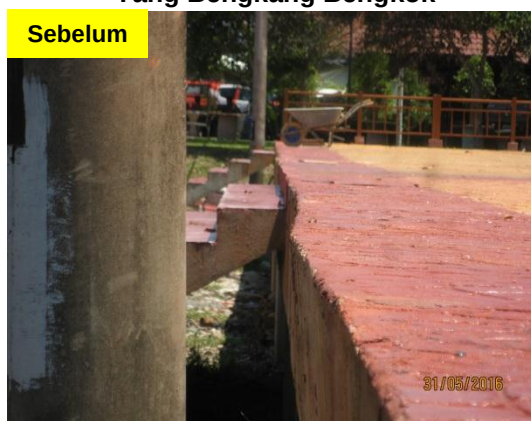
Gambar 3.8 Tepi Dataran Kejut Yang Bengkang Bengkok
