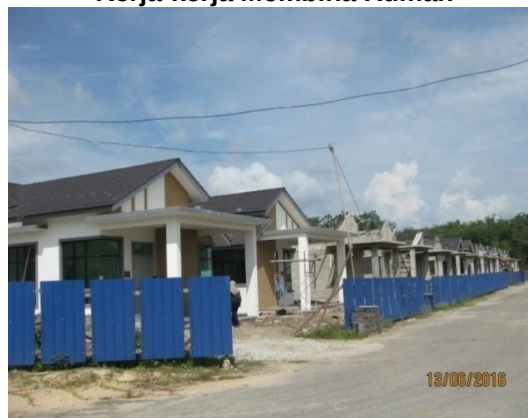
Gambar 4.2 Kerja-kerja Membina Rumah
