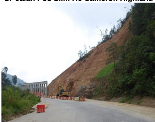
Gambar 1.5 Kerja-kerja Pembaikan Jalan Di Kilometer 27 Jalan Pos Slim Ke Cameron Highland
