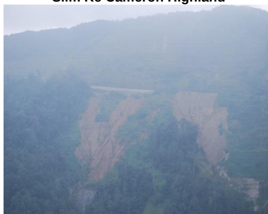
Gambar 1.6 Cerun Runtuh Di Kilometer 23.8 Jalan Pos Slim Ke Cameron Highland
