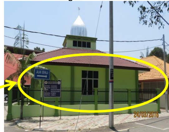
Gambar 4.4 Bilangan Tingkap Yang Dibina Tidak Mengikut Pelan Lukisan
