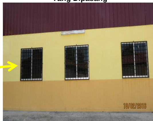
Gambar 4.8 Tingkap Berbingkai Kaca Yang Dipasang
