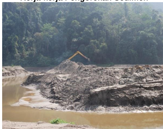
Gambar 1.4 Kerja-kerja Pengorekan Sedimen
