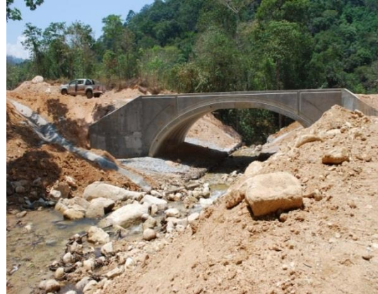
Gambar 1.2 Pembinaan Jalan Sedang Dibuat
