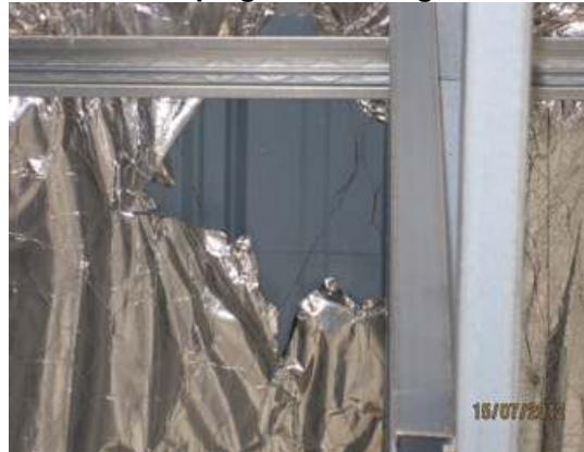
Gambar 3.40 Rockwool Tidak Dipasang Di Bawah Kepingan Bumbung
