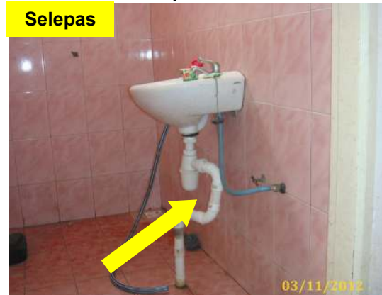
Gambar 3.28 Perangkap Sink Telah Dipasang Dan Paip Telah Dibaiki
