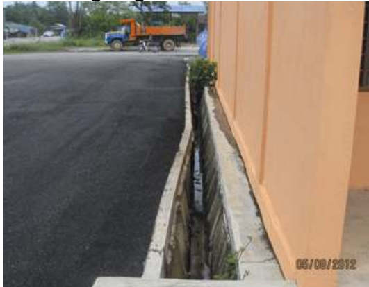
Gambar 3.11 Longkang Dibina Tidak Lurus
