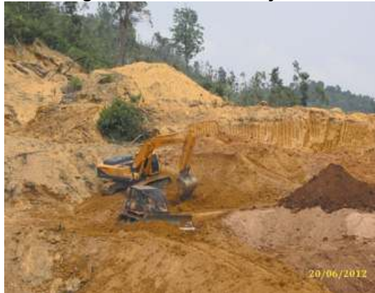
Gambar 5.1 Kerja-kerja Mengorek Tanah Untuk Mengenal Pasti Lokasi Bijih Besi
