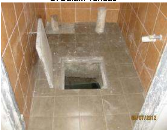
Gambar 3.31 Kedudukan Tangki Septik Di Dalam Tandas
