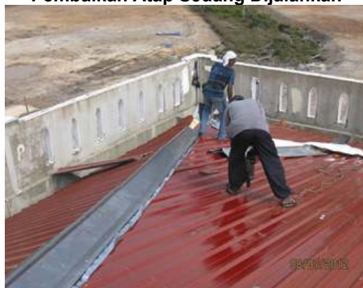
Gambar 3.47 Pembaikan Atap Sedang Dijalankan
