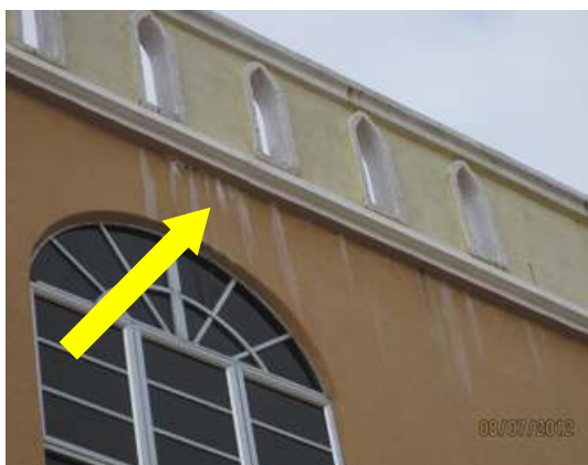
Gambar 3.23 Kesan Resapan Air Pada Bumbung
