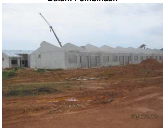
Gambar 2.3 Projek Rumah Mampu Milik Dalam Pembinaan
