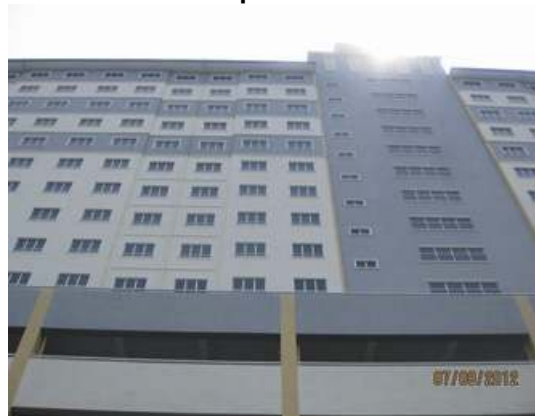
Gambar 2.2 Projek Rumah Pangsa Mampu Milik Siap Dibina
