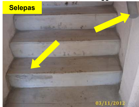
Gambar 3.30 Anak Tangga Telah Dipasang Nosing Tiles Dan Susur Tangga
