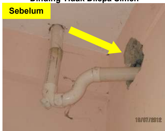
Gambar 3.5 Dinding Tidak Dilepa Simen
