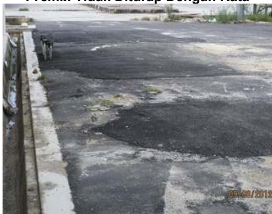
Gambar 3.19 Premix Tidak Ditutup Dengan Rata
