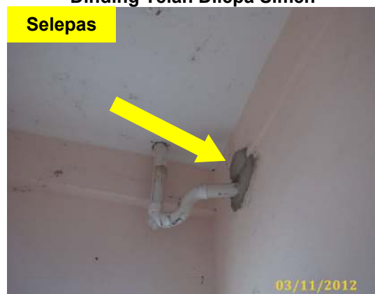
Gambar 3.6 Dinding Telah Dilepa Simen
