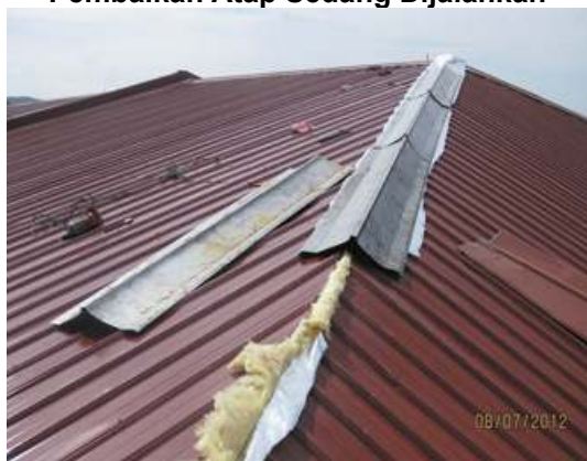
Gambar 3.46 Pembaikan Atap Sedang Dijalankan
