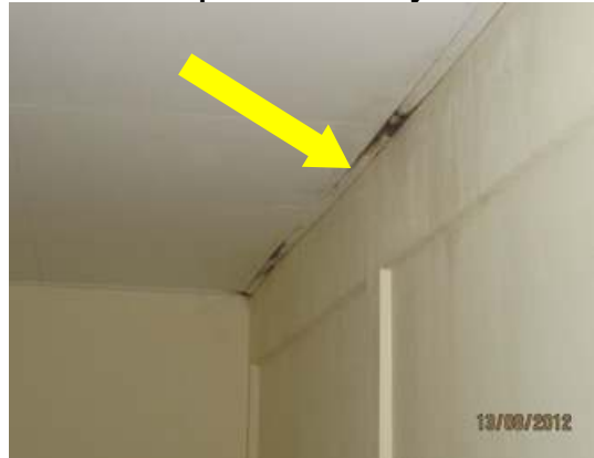
Gambar 3.12 Kesan Resapan Air Dan Kayu Berkulat
