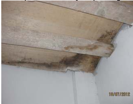
Gambar 3.9 Resapan Air Pada Kayu Lapik Tangki
