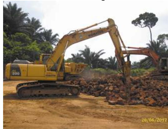
Gambar 5.2 Jentera Yang Digunakan Untuk Memecahkan Bongkah Batu
