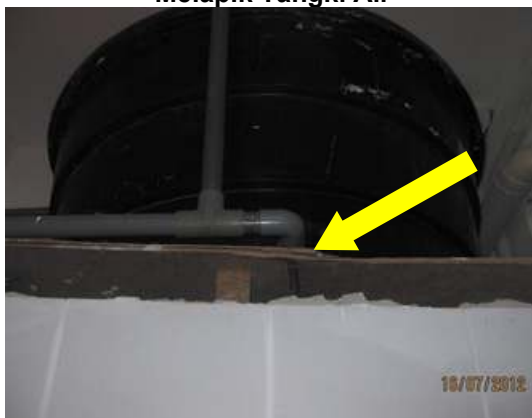
Gambar 3.21 Papan Terpakai Digunakan Bagi Melapik Tangki Air
