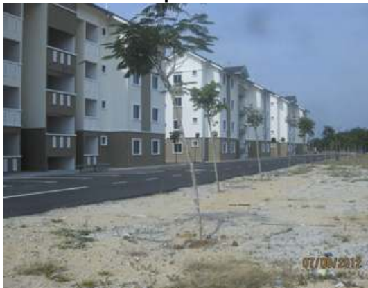
Gambar 2.1 Projek Rumah Pangsa Mampu Milik Siap Dibina
