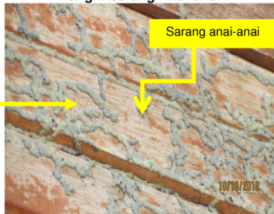
Gambar 2.21 Bahagian Kayu Di Chalet Yang Diserang Anai-anai
