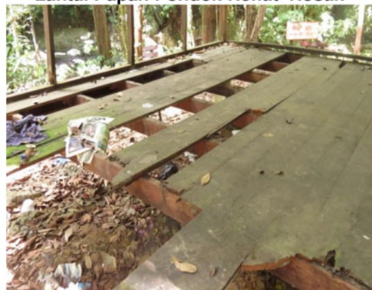
Gambar 2.25 Lantai Papan Pondok Rehat Rosak
