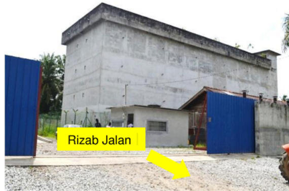
Gambar 1.10 Bangunan Burung Walet Di Atas Sebahagian Tanah Pertanian Dan Rizab Jalan
