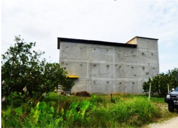
Gambar 1.9 Bangunan Burung Walet Di Atas Sebahagian Tanah Pertanian Dan Rizab Sungai
