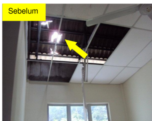
Gambar 3.1 Siling Asrama Tercabut
