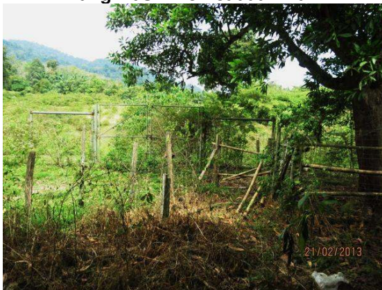
Gambar 2.9 Keadaan Pagar Cyclone Yang Masih Berkeadaan Baik
