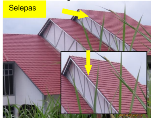
Gambar 3.4 Bumbung Telah Dibaiki
