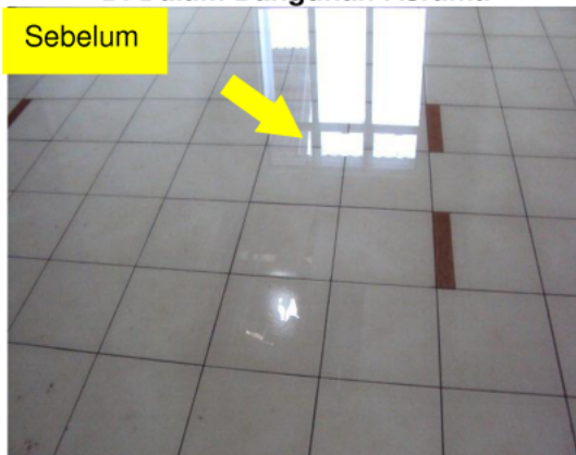
Gambar 3.5 Air Bertakung Di Dalam Bangunan Asrama
