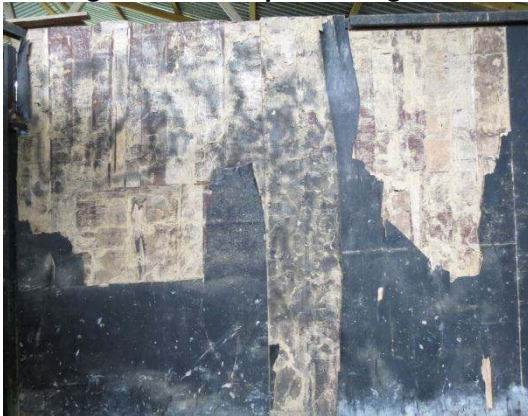
Gambar 2.15 Dinding Rumah Gelap Diserang Anai-anai
