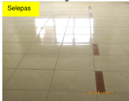
Gambar 3.6 Tiada Air Bertakung Di Dalam Bangunan Asrama
