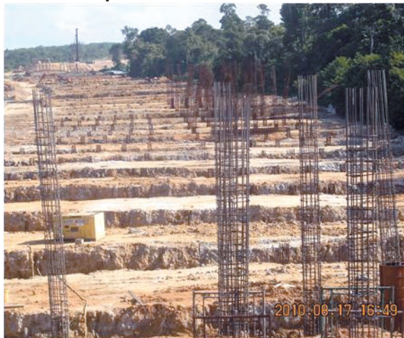
Gambar 11.3 Kerja Melantak Cerucuk Yang Belum Disiapkan Di Elevated Structure
