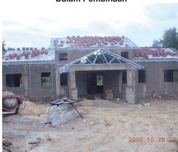
Gambar 7.6 Bangunan Perpustakaan Desa Putera Jaya Dalam Pembinaan
