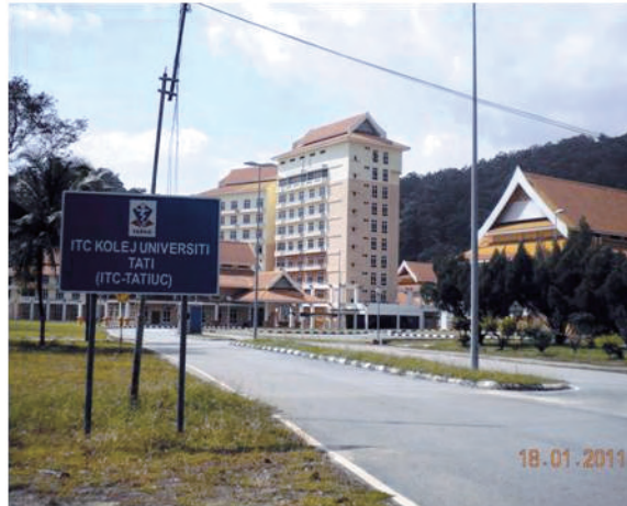
Gambar 10.1 Bangunan Asrama Di ITC Yang Dipinjamkan Oleh Kerajaan Negeri
