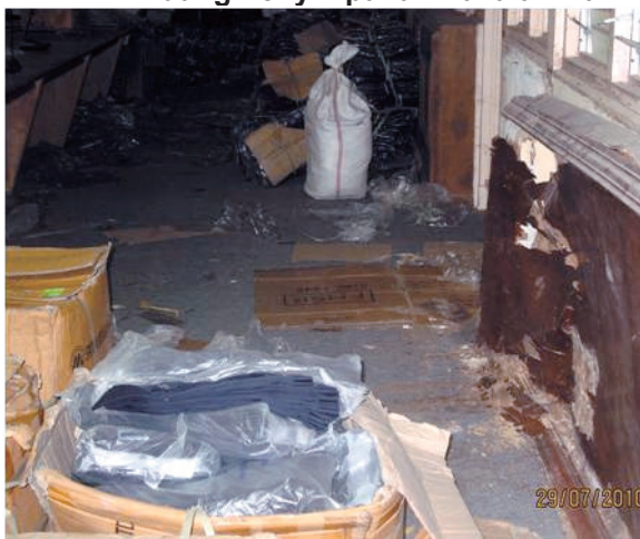
Gambar 2.5 Ruang Penyimpanan Pakaian Dan Alatan Sekolah Yang Diserang Anai-Anai
