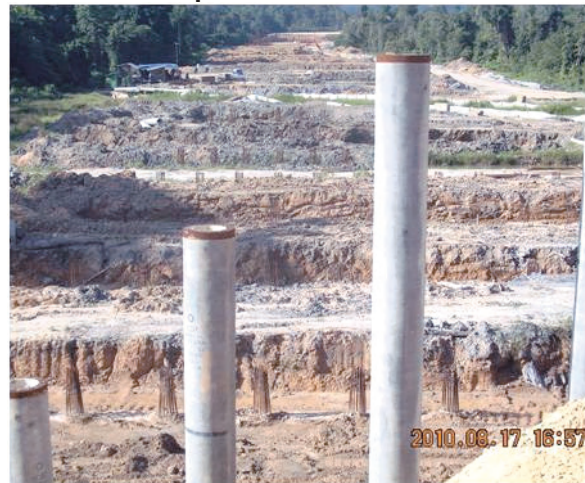
Gambar 11.4 Kerja Pemasangan Besi Tetulang Yang Belum Disiapkan Di Elevated Structure
