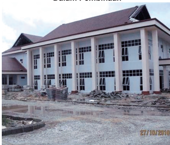
Gambar 7.4 Bangunan Perpustakaan Daerah Setiu Dalam Pembinaan
