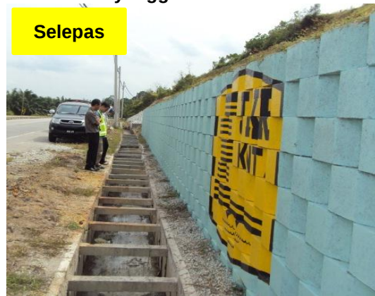
Gambar 1.2 Penyenggaraan Toe Drain
