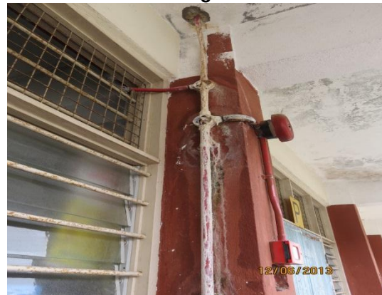
Gambar 2.18 Kesan Kebocoran Terkena Bahagian Konduit
