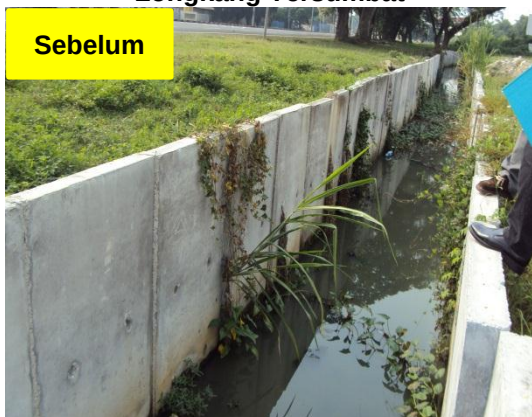
Gambar 1.15 Air Bertakung Kerana Longkang Tersumbat
