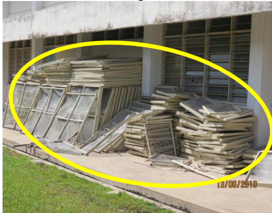
Gambar 2.23 Jaring Nyamuk Yang Rosak Tidak Digunakan
