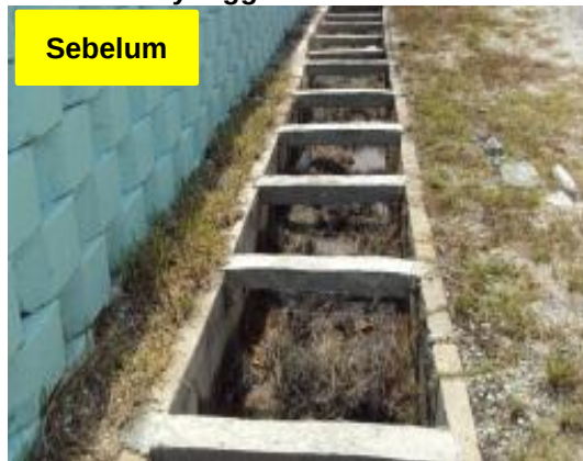
Gambar 1.1 Penyenggaraan Toe Drain
