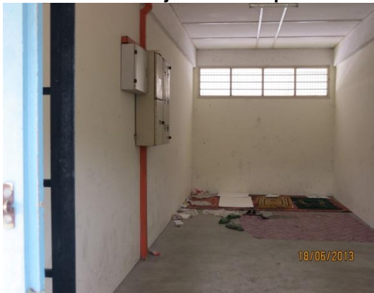
Gambar 2.33 Bilik Elektrik Dijadikan Tempat Solat
