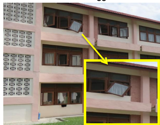
Gambar 2.22 Tingkap Asrama Yang Hampir Tercabut Atau Tertanggal
