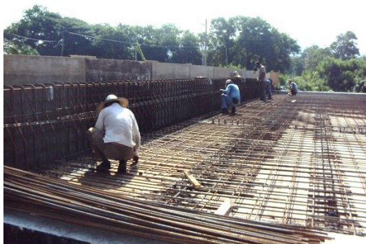
Gambar 3.12 Jambatan Pertama Masih Dalam Pembinaan
