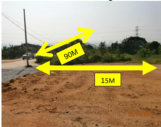
Gambar 3.9 Pembinaan Jalan Tergendala
