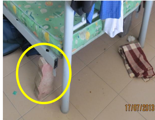
Gambar 2.16 Besi Katil Rosak Dilapik Dengan Bata
