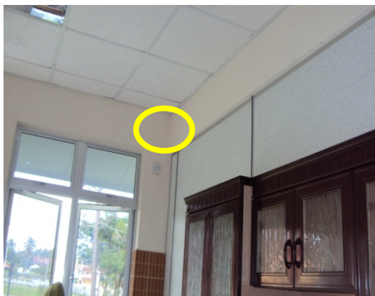
Gambar 5.1 Lokasi Wall Exhaust Fan Perlu Disediakan
