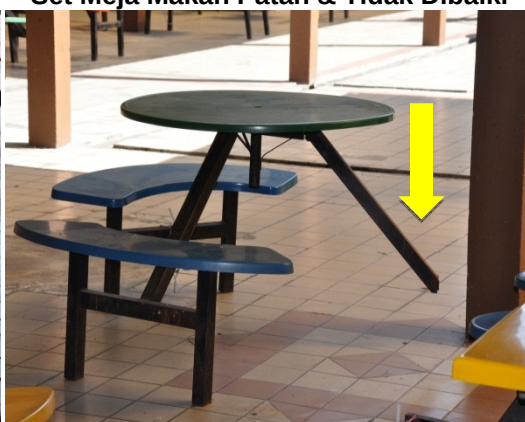
Gambar 8.4 Set Meja Makan Patah & Tidak Dibaiki
