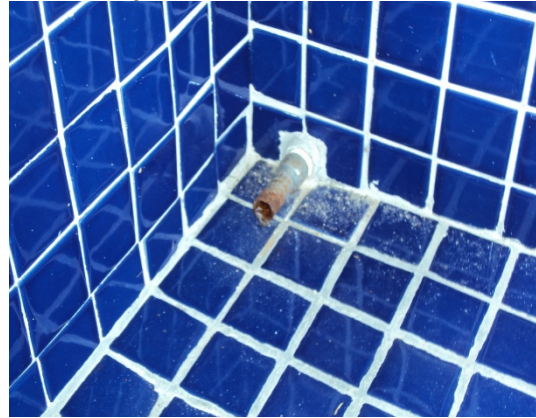
Gambar 5.12 Besi Paip Berkarat Di Dasar Kolam
