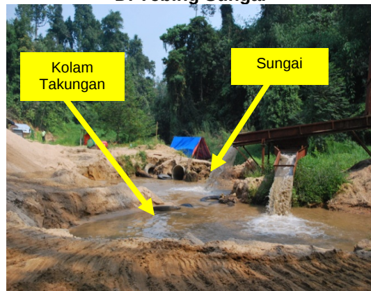
Gambar 2.12 Kolam Takungan Pasir Dan Struktur Pam Di Tebing Sungai
