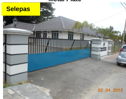
Gambar 5.23 Pintu Besi Gelongsor Yang Dipasang Metal Plate
