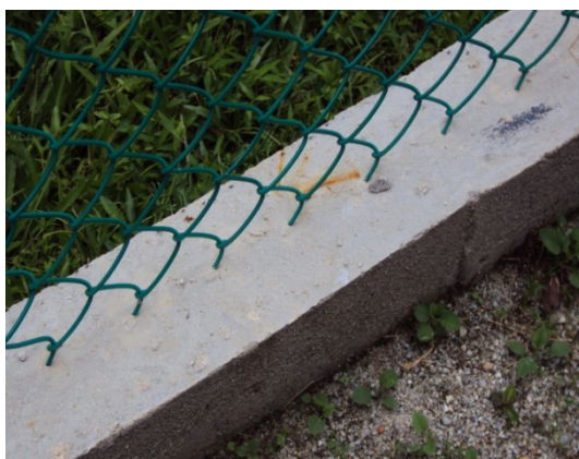
Gambar 5.16 Pagar Yang Ditanam Di Ground Beam
