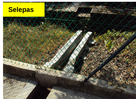
Gambar 5.20 Longkang Yang Telah Dibaiki
