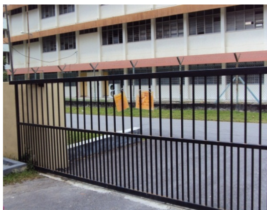
Gambar 5.22 Pintu Besi Gelongsor Yang Tidak Sesuai
