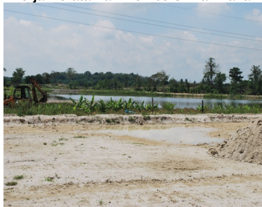
Gambar 3.6 Kerja Merata Dan Membersihkan Tanah
