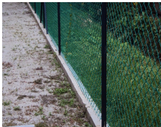
Gambar 5.15 Keadaan Pagar Yang Baik
