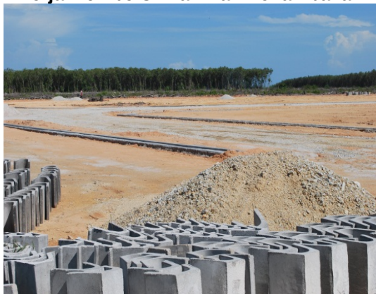
Gambar 3.5 Kerja Membersihkan Dan Penambakan
