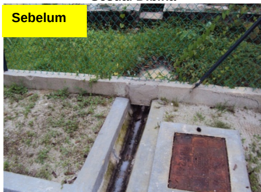
Gambar 5.19 Panjang Longkang Yang Tidak Sesuai Dibina
