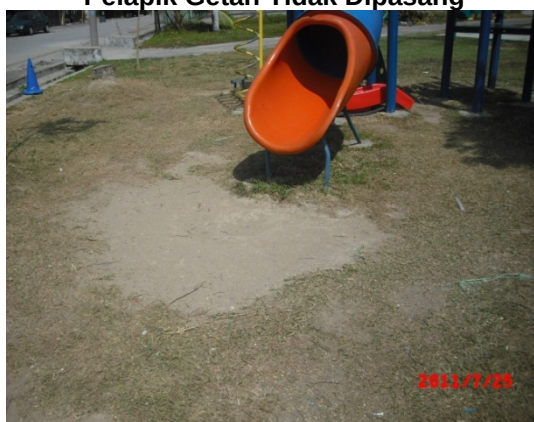
Gambar 7.5 Pelapik Getah Tidak Dipasang
