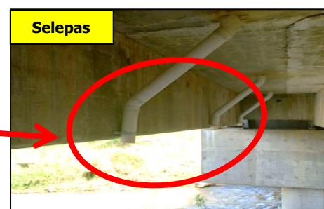
Jambatan Similajau - Pemasangan Paip Pembentungan uPVC Telah Dibuat (21.01.2020) (Sumber: JKR Sarawak)
