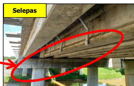
Jambatan Similajau - Tindakan Pemasangan Paip Pembentungan uPVC Pada Struktur Konkrit (21.01.2020) (Sumber: JKR Sarawak)
