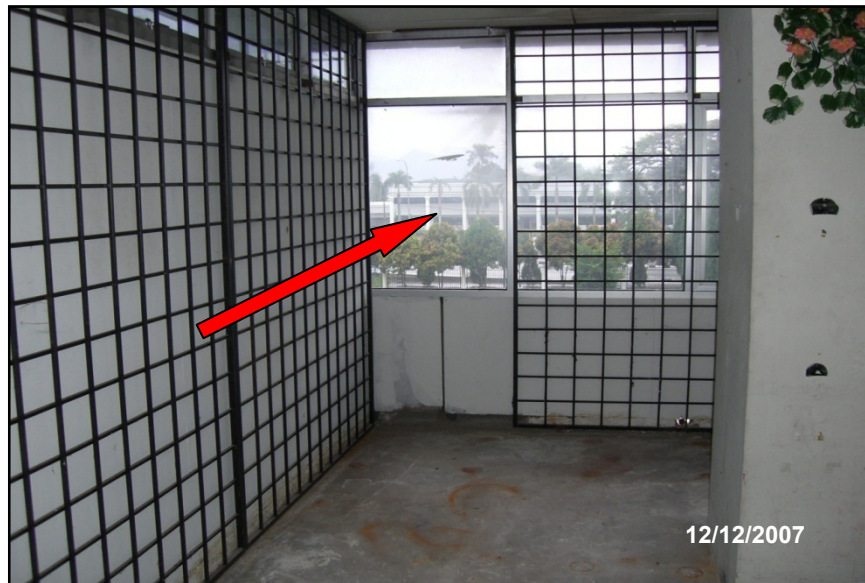
Foto 29 Kerja Pemasangan Jeriji Besi Belum Siap
