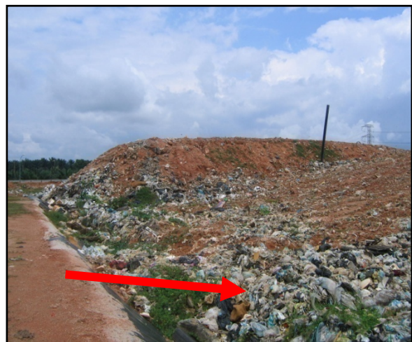
Foto 82 Sampah Tidak Dikambus Dengan Sempurna
