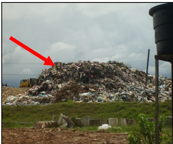
Foto 81 Sampah Tidak Dikambus Dengan Tanah Merah
