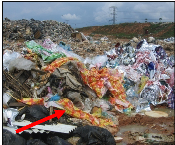
Foto 90 Sampah Di Tapak Belum Dikampus Dengan Tanah
