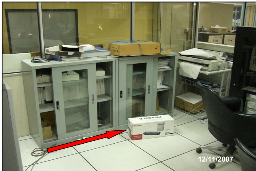
Foto 28 Bahan Mudah Terbakar Dalam Bilik Server PTD Manjung
