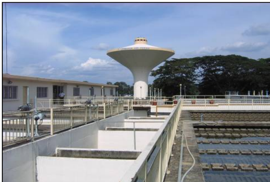
Foto 42 Loji Rawatan Air Kg. Paloh Yang Telah Dinaiktaraf
