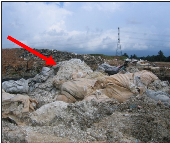
Foto 89 Sampah Di Tapak Tidak Dikampus Dengan Tanah
