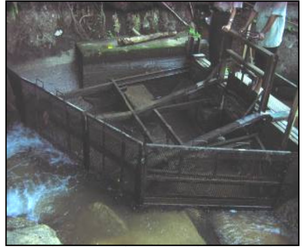
Foto 47 Strainer Muka Sauk Yang Sering Tersumbat
