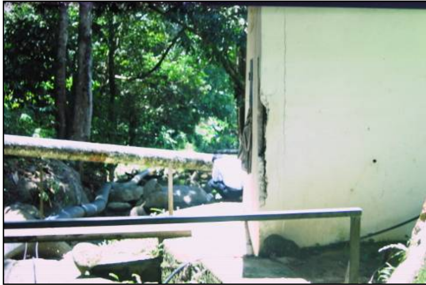
Foto 57 Rumah Pre- Chlorine Yang Tidak Digunakan
