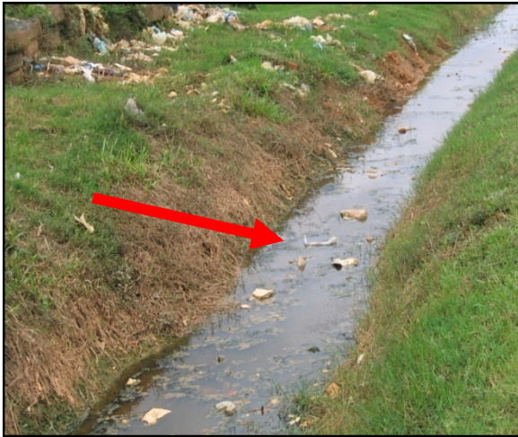
Foto 95 Air Hujan Bertakung Di Parit Dan Bercampur Air Resapan Yang Mengalir Dari Cerun Tapak
