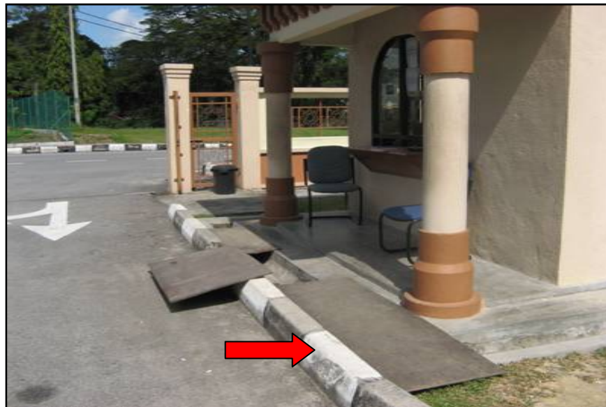
Foto 37 Longkang Ditutup Dengan Papan Lapis
