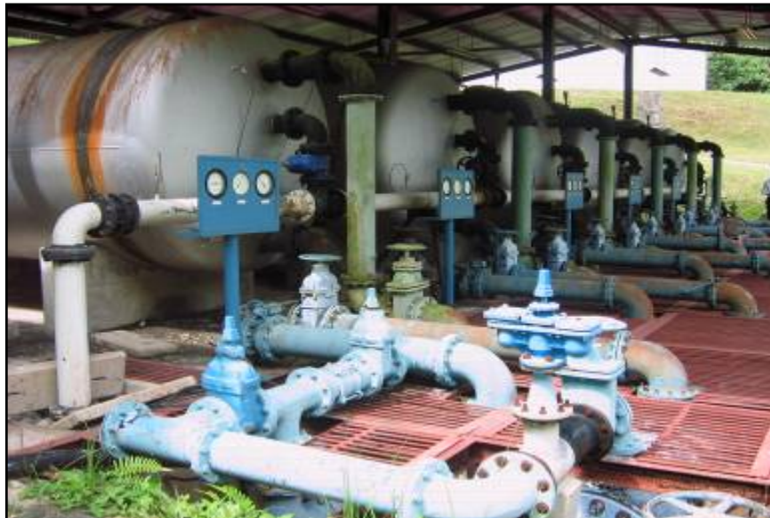
Foto 45 Horizontal Pressure Filter Yang Tidak Disenggarakan Dengan Baik
