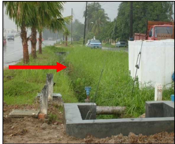
Foto 65 Rumput Tidak Dipotong
