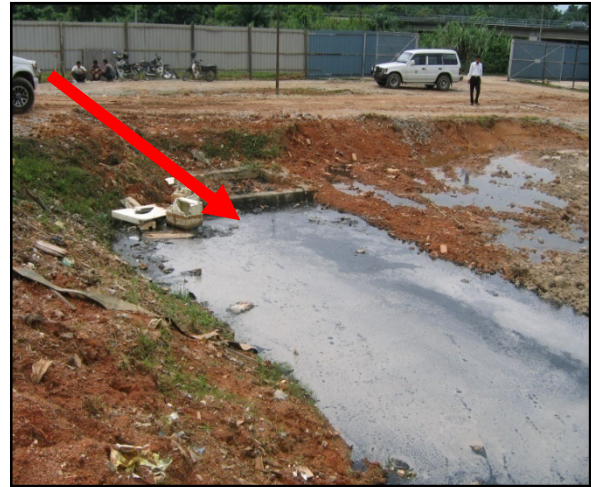
Foto 96 Parit Dipenuhi Air Resapan Dan Bercampur Air Hujan
