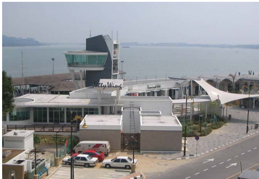
Foto 29 Terminal Jeti Lumut
