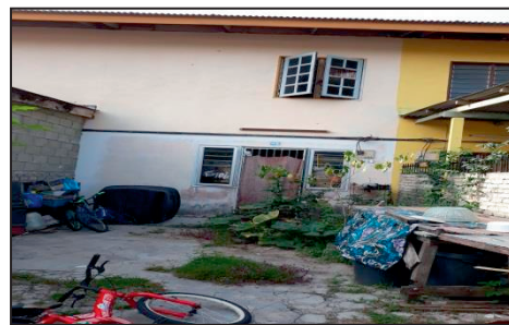
PAKR Sg. Lui, Raub - Rumah Kosong Tidak Disenggara dengan Baik (13.03.2019) (Sumber: Jabatan Audit Negara)
