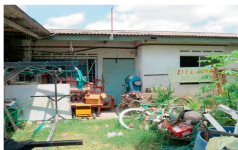
PAKR Sg. Isap, Kuantan - Rumah Penyewa Tidak Diduduki (05.03.2019) (Sumber: Jabatan Audit Negara)
