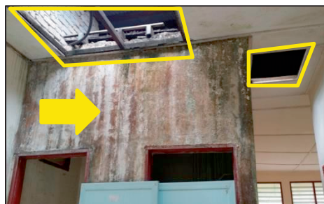
PAKR Sg. Pandan, Kuantan - Kerosotan Bahan Bumbung, Siling dan Cat (13.02.2019) (Sumber: Jabatan Audit Negara)
