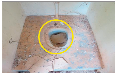
PAKR Sg. Pandan, Kuantan - Lubang Tandas Tersumbat (13.02.2019) (Sumber: Jabatan Audit Negara)
