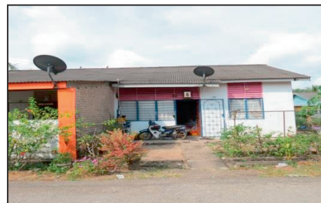
PAKR Panching, Kuantan - Rumah yang Disewakan kepada Pihak Lain (07.03.2019) (Sumber: Jabatan Audit Negara)
