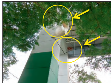
Jalan Kuantan - Gambang - Paparan Visual Papan Iklan Koyak dan Besi Struktur Papan Iklan Tercabut (11.12.2017)
