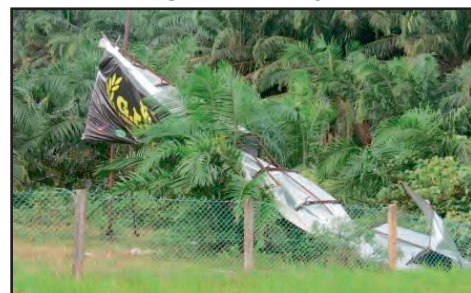
LPT KM222.9 Menghala ke Terengganu - Papan Iklan Telah Roboh (23.11.2017)
