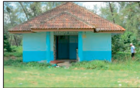
Tandas Awam Balok - Meter Tidak Dijumpai (20.12.2017)
