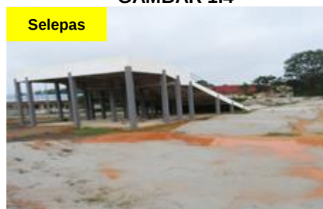
Gelanggang BMX, Kompleks SUKPA - Hamparan Quarry Dust Telah Dilaksanakan (September 2018) (Sumber: JKR Daerah Kuantan)
