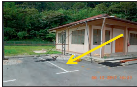
Tempat Letak Kereta, Baitul Islah - Kerja Membina Bumbung Tempat Letak Kereta Sedang Dijalankan (06.12.2017)
