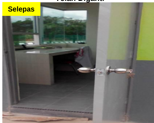
Gambar 4.12 Concrete Counter Top Telah Dibuat, Lantai Telah Berjubin Dan Tombol Pintu Telah Diganti
