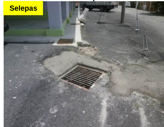
Gambar 4.16 Permukaan Dataran Kejut Yang Telah Dibaiki Dan Diperkemas
