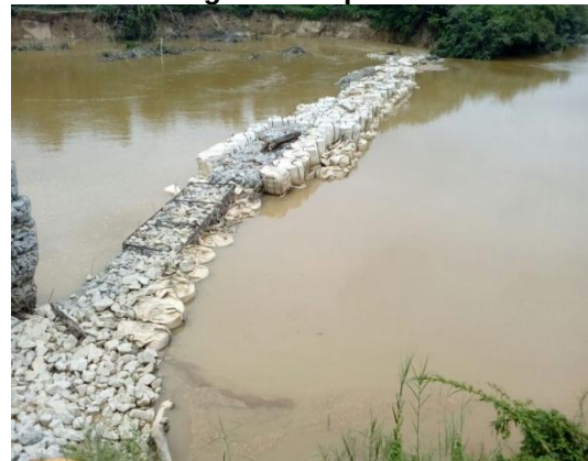
Gambar 2.7 Gabion Di Muka Sauks Bukit Sagu Yang Telah Diperbaiki
