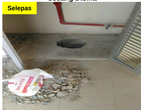
Gambar 1.30 Saluran Paip Air Buangan Sedang Dibina
