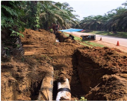
Gambar 2.8 Kerja Pemasangan Paip Untuk Air Terawat Ke LRA Bukit Goh
