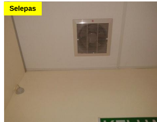
Gambar 1.34 Exhaust Fan Telah Dipasang
