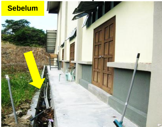
Gambar 3.30 Pemasangan Paip PVC Tidak Sempurna
