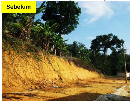
Gambar 3.34 Kabel Elektrik Yang Membahayakan
