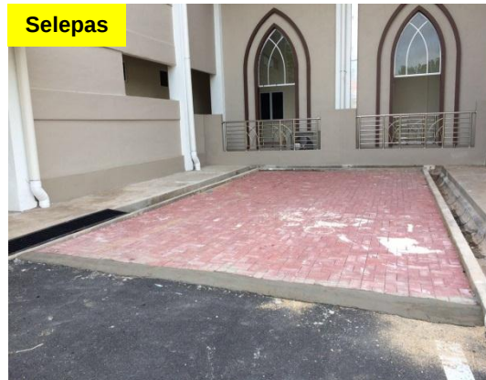
Gambar 1.20 Pemasangan Interlocking Telah Dikemaskan
