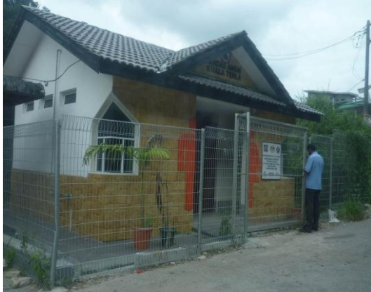
Gambar 4.5 Tandas Berkunci Dan Tidak Digunakan
