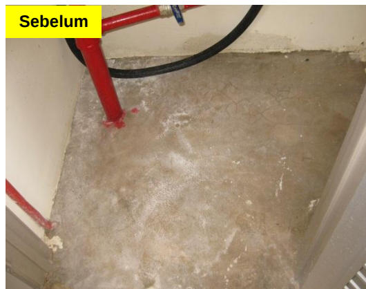
Gambar 1.29 Saluran Paip Air Buangan Tidak Dibina
