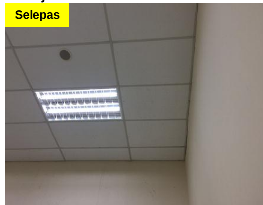
Gambar 1.10 Kerja Pembaikan Telah Dilaksanakan
