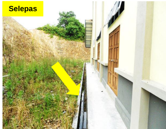
Gambar 3.31 Paip PVC Telah Dibaiki
