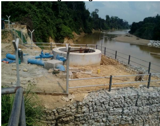
Gambar 2.6 Horizontal Collecting Well Yang Sedang Dibina
