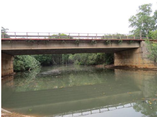
Gambar 2.11 Keadaan Sungai Nyior Di Jambatan
