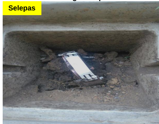
Gambar 1.32 Pemasangan Earth Electrode Telah Dilabel Mengikut Spesifikasi
