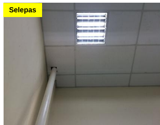
Gambar 1.12 Kerja Pembaikan Telah Dilaksanakan
