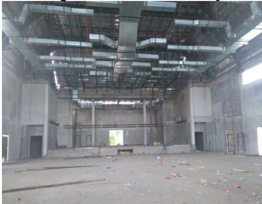
Gambar 3.9 Ruang Utama Dewan Konvensyen
