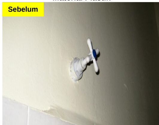
Gambar 1.35 Stopcock Menggunakan Material Plastik
