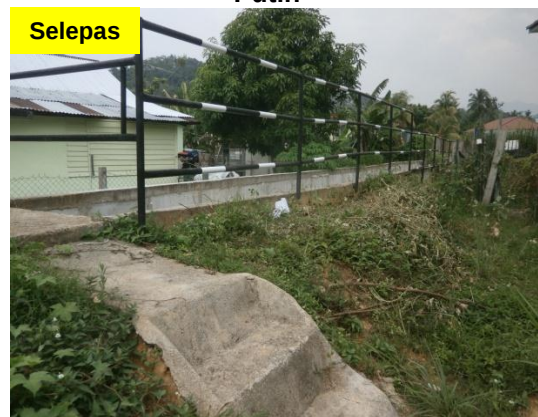
Gambar 4.8 Railing Keselamatan Telah Dicat Hitam Putih
