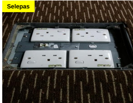
Gambar 1.26 Pemasangan Suis Telah Dikemaskan
