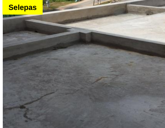
Gambar 1.14 Saliran Air Tersumbat Telah Diperbaiki
