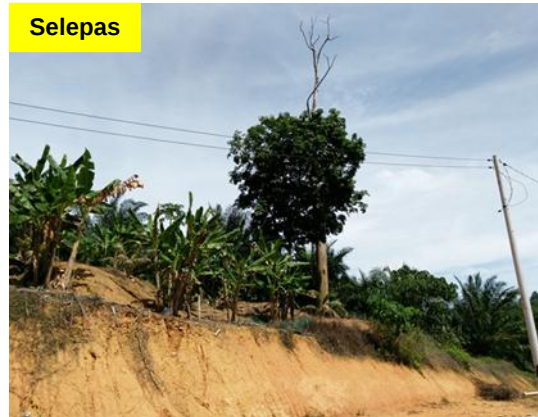
Gambar 3.35 Kabel Elektrik Telah Dibaiki
