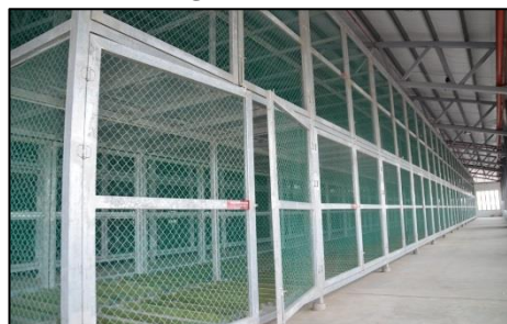
Kotak Ikan, PPLTB - Kotak Ikan yang Tidak Digunakan (03.10.2019) (Sumber: Jabatan Audit Negara)
