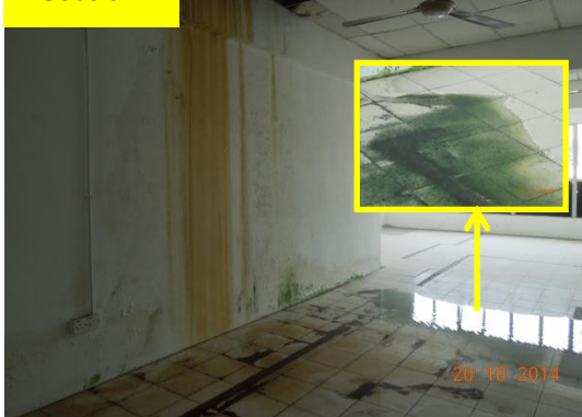
Gambar 4.11 Limpahan Air Tangki Dari Atas Siling Hingga Membanjiri Lantai
