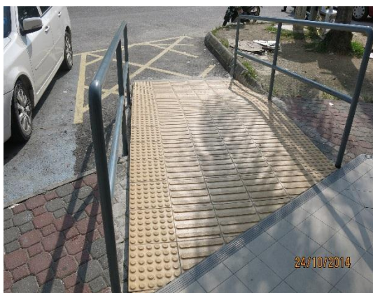
Gambar 2.1 Kedudukan Kerja Membina Ramp , Kemasan Precast Compress Tiles Serta Kerja Membekal Dan Memasang Railing Semasa Pemeriksaan Audit Dijalankan
