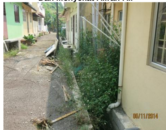
Gambar 2.5 Tumbuhan Liar Tidak Dibuang Sehingga Memenuhi Longkang Dan Menyekat Aliran Air
