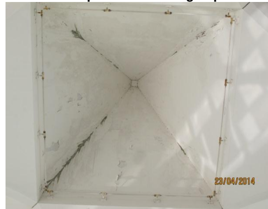
Gambar 1.14 Kegagalan Lapisan Kalis Lembap Menyebabkan Cat Pada Permukaan Bawah Beberapa Piramid Mengelupas
