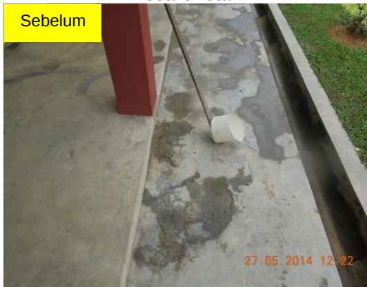
Gambar 4.9 Lantai Kaki Lima Bilik Pengajian Pecah/Retak
