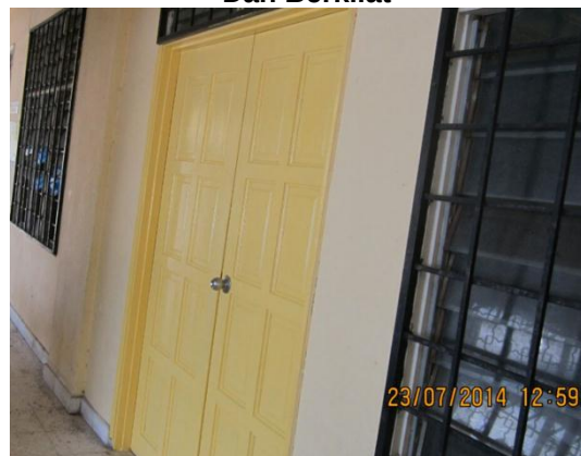
Gambar 1.18 Salah Satu Pintu Yang Telah Siap Dicat Dengan Teknik Yang Betul Kelihatan Licin Dan Berkilat
