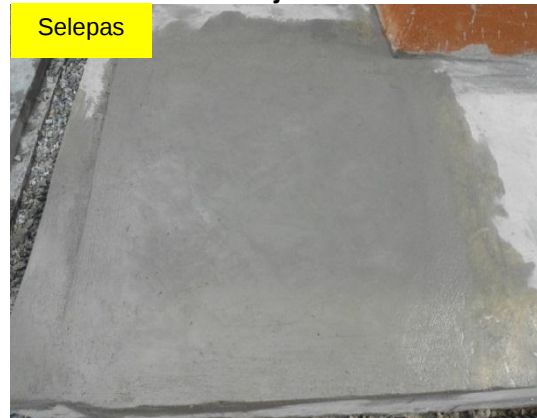
Gambar 4.6 Kerja Menyimen Semula Siar Kaki Surau Telah Dijalankan
