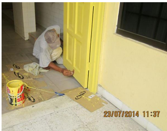
Gambar 1.17 Kontraktor Sedang Membaiki Cat Salah Satu Panel Pintu
