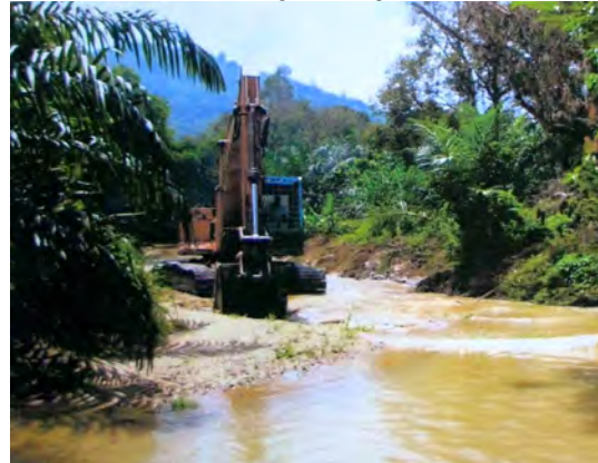
Gambar 3.2 Kerja Mengorek Sungai Chalit, Raub Sedang Dilaksanakan Pelaksanaan Kerja 7 September 2011
