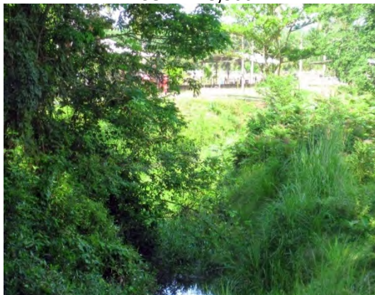
Gambar 3.7 Keadaan Sungai Sekor, Pekan Pelaksanaan Kerja 25 Mac 2011 Kos RM18,500
