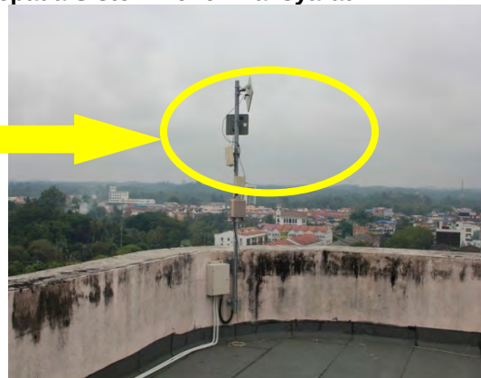
Gambar 8.1 CCTV Tidak Berfungsi Dan Tidak Dapat Memberi Imej Gambar Kepada Sistem Penerima Isyarat
