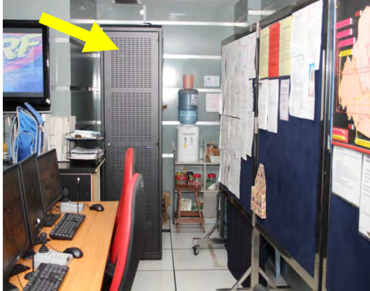
Gambar 8.5 Lokasi Server Di IPD Kuantan
