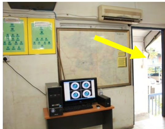
Gambar 8.10 Bilik Kawalan CCTV di IPD Temerloh Tidak Mempunyai Kawalan Akses
