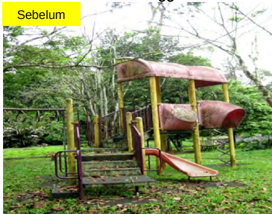
Gambar 6.6 Taman Permainan Tidak Disenggara
