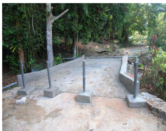
Gambar 6.10 Jambatan Kayu Telah Diganti Dengan Jambatan Culvert
