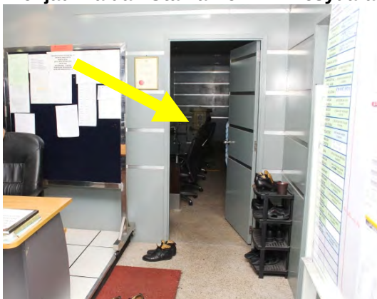
Gambar 8.9 Bilik Kawalan CCTV di IPD Kuantan Tidak Mempunyai Kawalan Akses Dan Menjadi Laluan Utama Ke Bilik Mesyuarat
