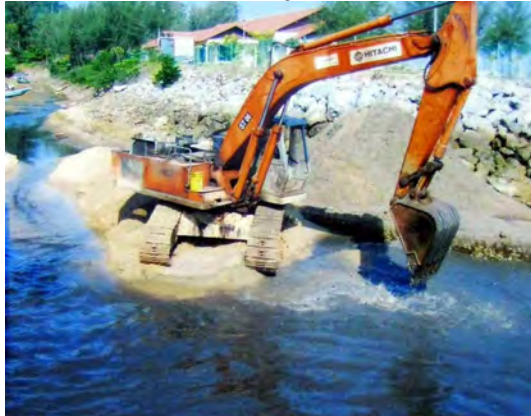
Gambar 3.1 Kerja Mengorek Sungai Tekek, Pulau Tioman Sedang Dilaksanakan Pelaksanaan Kerja 20 Jun 2011
