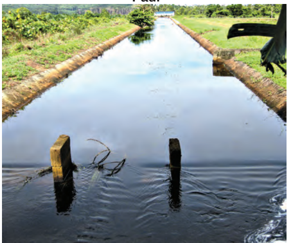
Foto 12.4 Saliran Yang Digunakan Bagi Mengairi Sawah Padi
