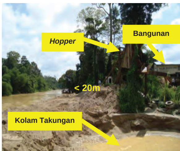
Foto 6.7 Kedudukan Hopper , Kolam Takungan Dan Bangunan Kurang 20m Dari Tebing Sungai
