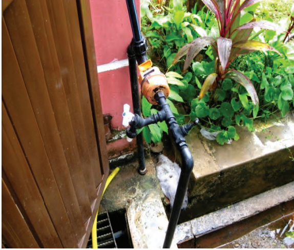
Pemasangan Paip Sebelum Meter
