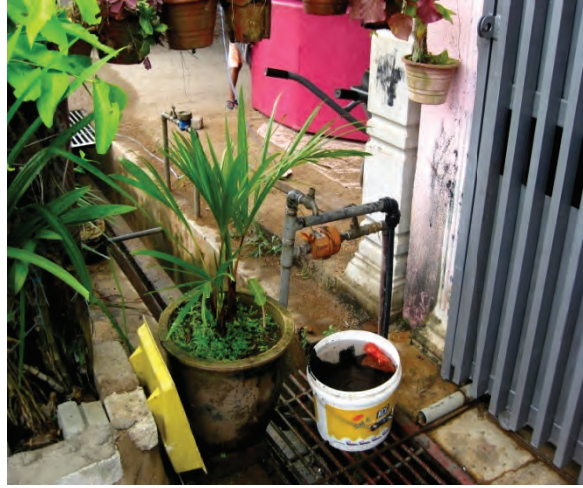
Pemasangan Paip Sebelum Meter
