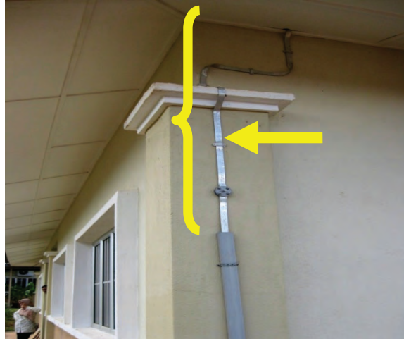
Foto 4.10 Bahan Aluminium Digunakan Sebagai Pita Pbumian Kilat
