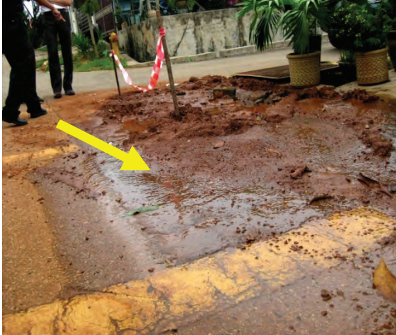
Foto 8.6 Kebocoran Berulang
