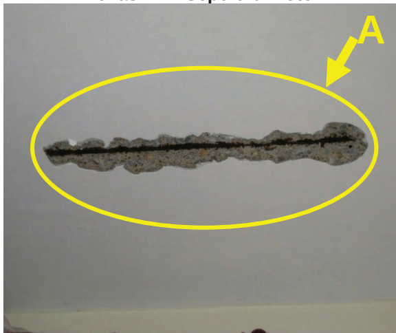
Foto 4.2 Pandangan Dekat Pengelupasan Konkrit Di Lokasi "A" Seperti di Foto 4.1
