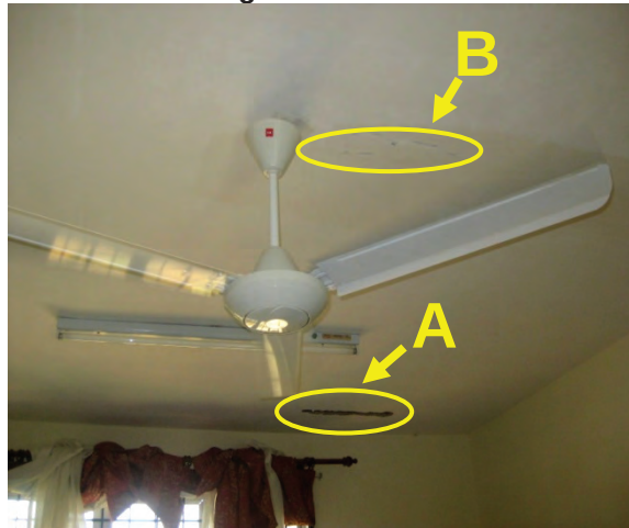
Foto 4.1 Pengelupasan Konkrit Di Bahagian Bawah Lantai Konkrit Tingkat Atas Bangunan Asrama
