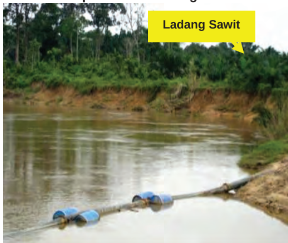
Foto 6.11 Tebing Sungai Berhampiran Ladang Kelapa Sawit Yang Mengalami Gelongsoran Tanah Kesan Daripada Aktiviti Pengambilan Pasir
