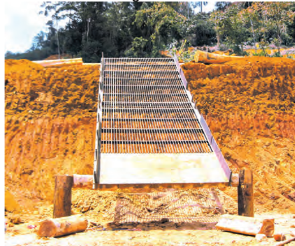
Foto 13.4 Alat Yang Digunakan Sebagai Penapis Bagi Mengasingkan Bijih Besi Yang Bercampur Dengan Tanah
