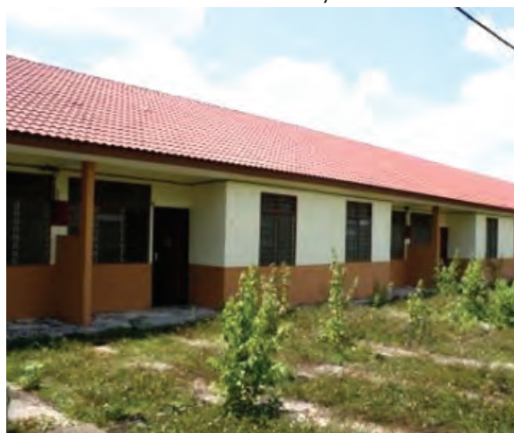
Foto 2.14 Sebahagian Rumah Yang Masih Kosong Di PPRM Bolok Hilir, Temerloh
