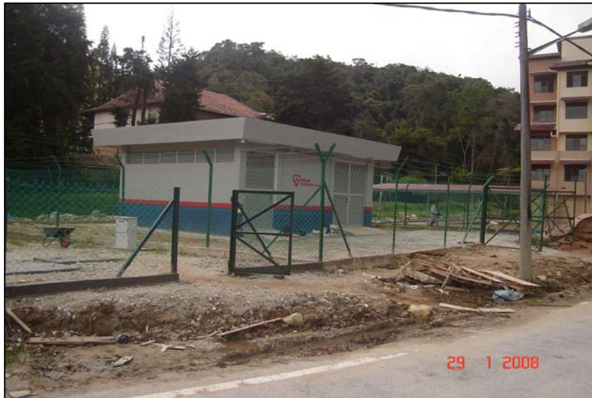
Foto 61 Bangunan Sub-Station TNB
