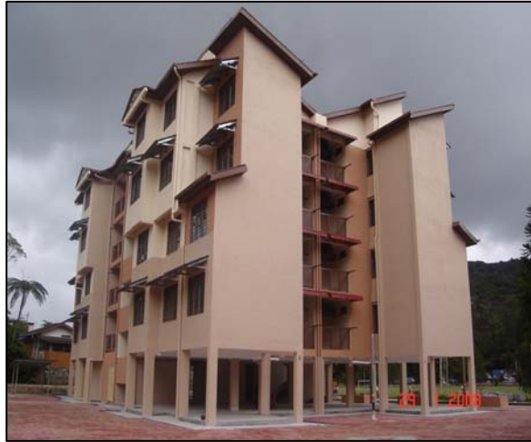
Foto 52 Bangunan Kuarters Yang Telah Siap
