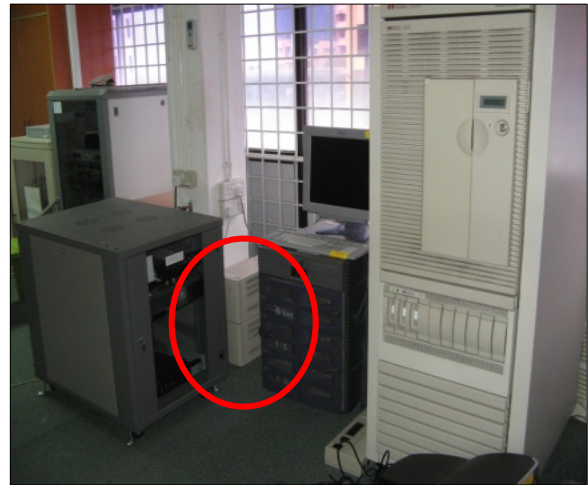
Foto 11 Penggunaan Uninterrupted Power Supply Di Bilik Server PDT Kuantan
