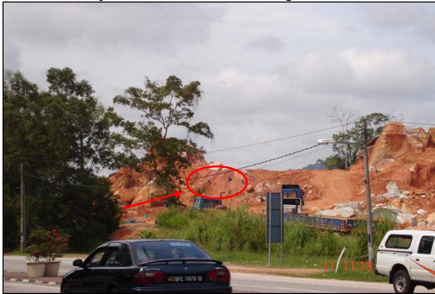
Foto 48 Kerja Pemecahan Batu Sedang Dilakukan
