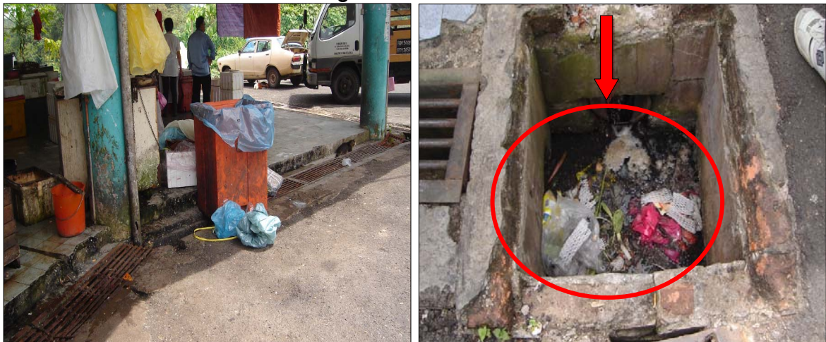
Foto 90 Foto 91 Keadaan Longkang Di Sekeliling Pasar Besar Kuala Lipis Yang Tidak Dibersihkan
