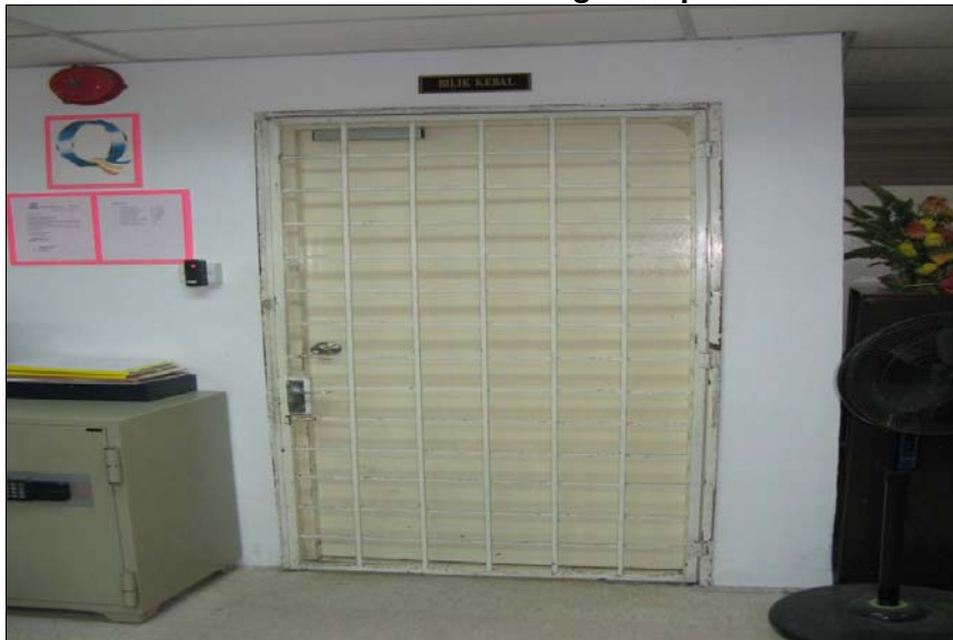
Foto 16 Pintu Bilik Kebal Tidak Mengikut Spesifikasi
