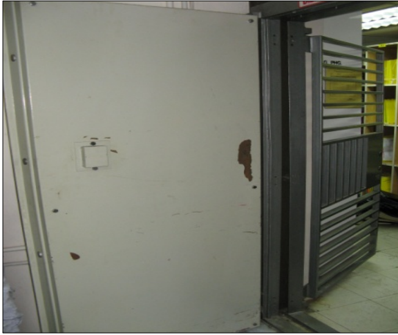
Foto 14 Pintu Bilik Kebal Mengikut Spesifikasi PTG
