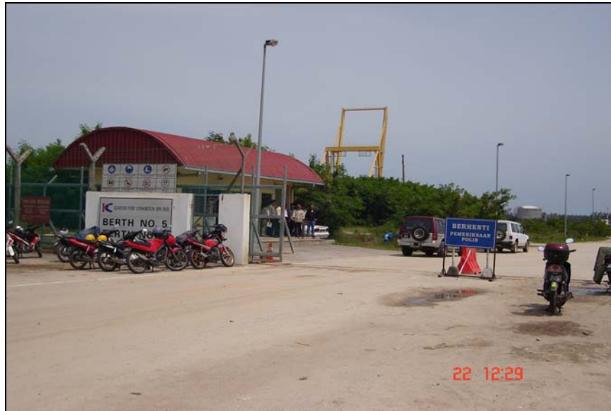
Foto 45 Pintu Masuk Lori Ke Pelabuhan Kuantan
