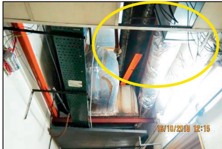
Laluan Utama Pekerja ke Lobi Hotel, ESSB - Keadaan Wayar Elektrik di Bahagian Siling yang Terdedah (16.10.2018) (Sumber: Jabatan Audit Negara)
