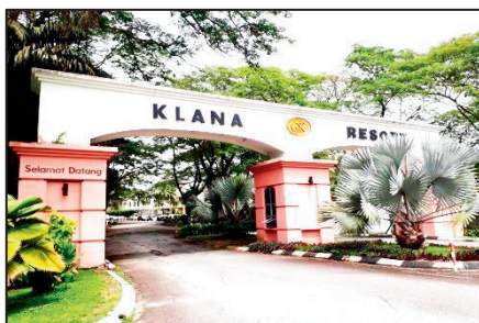
Emerald Spirit Sdn. Bhd. - Pintu Masuk Utama ke Kawasan Hotel Tidak Dilengkapi Dengan CCTV (13.11.2018) (Sumber: Jabatan Audit Negara)
