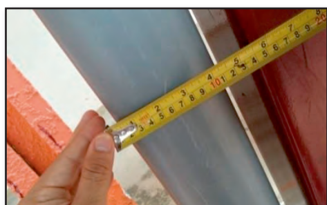
Susur Gajah PDTKP 100mm Diameter Salur Tegak Air Hujan (08.11.2017)
