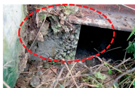
Jambatan di Kg. Jawa - Tiada Bearing Plate Dipasang pada Struktur Jambatan (07.11.2017)
