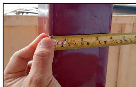
Susur Gajah PDTKP Pemasangan Tiang 100mm x 100mm (08.11.2017)
