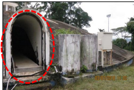
Kolam Imbangan Bukit Gun, Seremban - Antara Saluran Injap Air Tidak Bertutup (03.07.2018)
