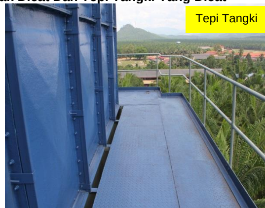
Gambar 2.6 Perbezaan Kawasan Atas Tangki Tidak Dicat Dan Tepi Tangki Yang Dicat
