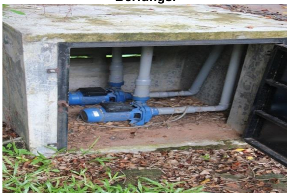
Gambar 3.3 Pam Peralatan Permainan Air Yang Tidak Berfungsi
