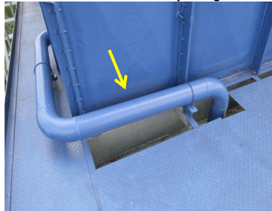
Gambar 2.4 Tiada Penandaan Arah Anak Panah Air Masuk/Keluar Pada Paip Tangki Air
