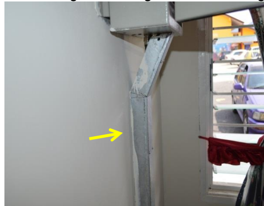
Gambar 2.2 Pemasangan Trunking Terus Ke Dinding
