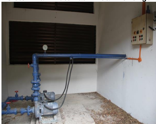
Gambar 2.11 Sistem Pam Automatik Tidak Berfungsi
